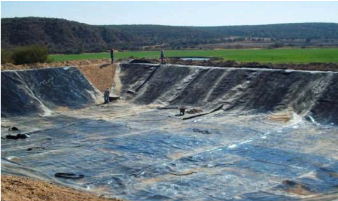
Figura 2.9 Instalación membrana impermeabilizante. Fuente: http://www.biogemex.net
