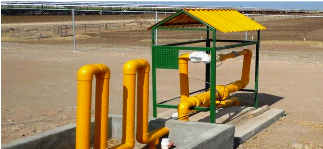
Figura 2.12 Filtro de Biogás. Fuente: http://www.biogemex.net
