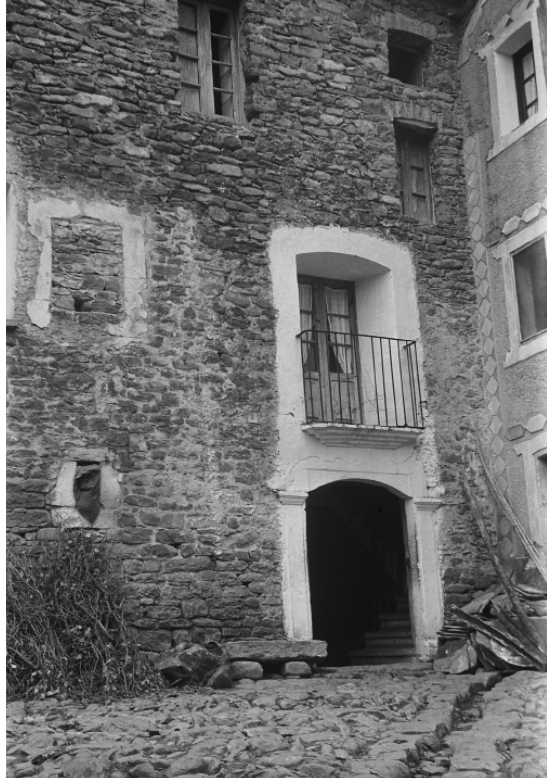
Imagen 1.23. Ambiente de una gran casa de Jánovas, años 50, con usos auxiliares en planta baja y vivienda en plazas superiores. Pavimentos con piezas de piedra natural con formato cuadrangular apoyados en bandas de encintado transversal. Tanto esta imagen como las de la 1.25 son de Ricardo Agramunt Nasarre, fotógrafo de Boltaña cuyo archivo emplea el restaurador (Plan Especial de Jánovas).
