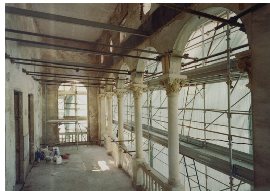
Fig. 57 Refuerzo de la estructura en la galería del Kursaal.
