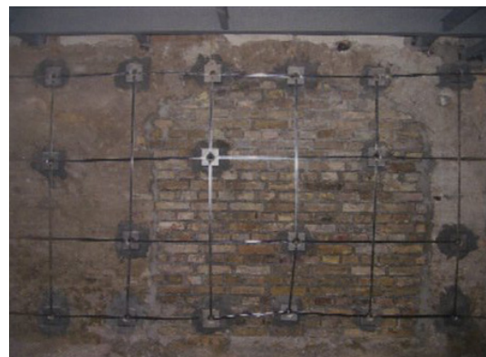
Fig. 58 Refuerzo de los muros mediante el sistema CAM.
