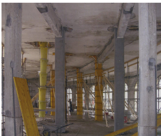
Fig. 56 Encamisado de los pilares.
