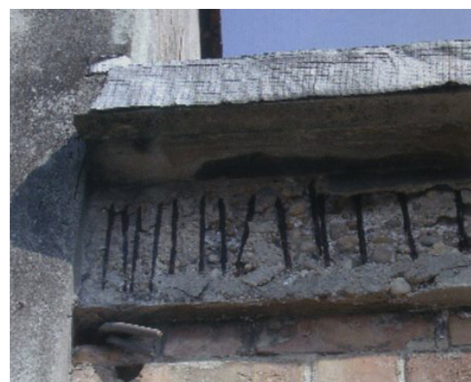
Fig. 52 Afloramiento de las armaduras en el hormigón.
