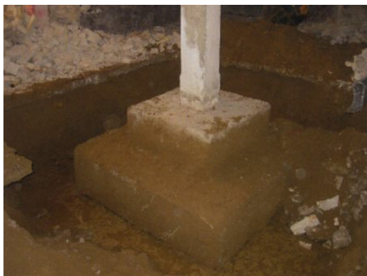
Fig. 55 Sondeo de la cimentación.
