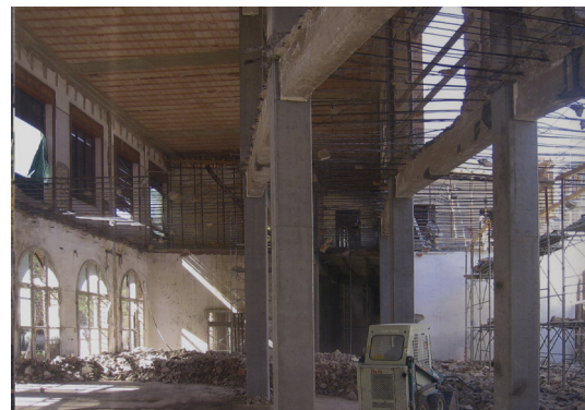
Fig. 59 Eliminación de la tabiquería interior.
