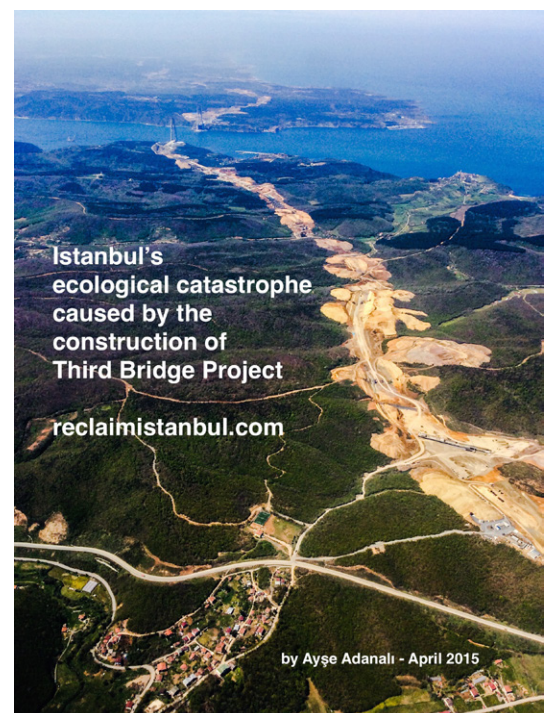
Figura 7. Construcción del tercer puente sobre el Bósforo. Abril de 2015. Reclaimistanbul.com
