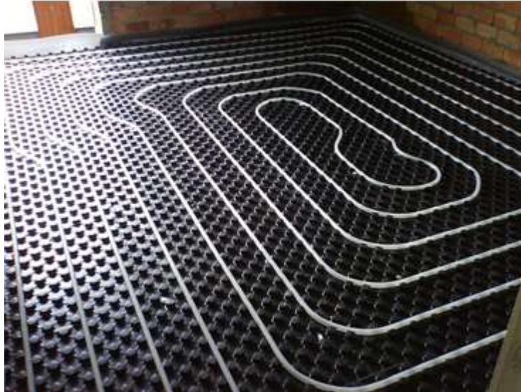
Figura 9 Suelo radiante
