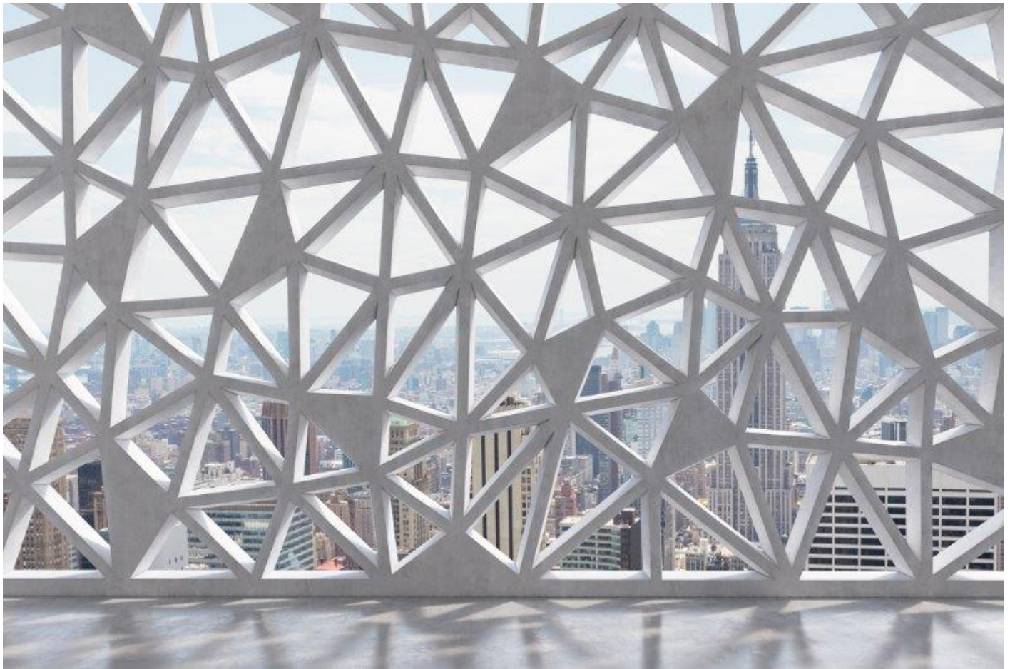
Figura 15 Fachada realizada con HUAC en Nueva York.
