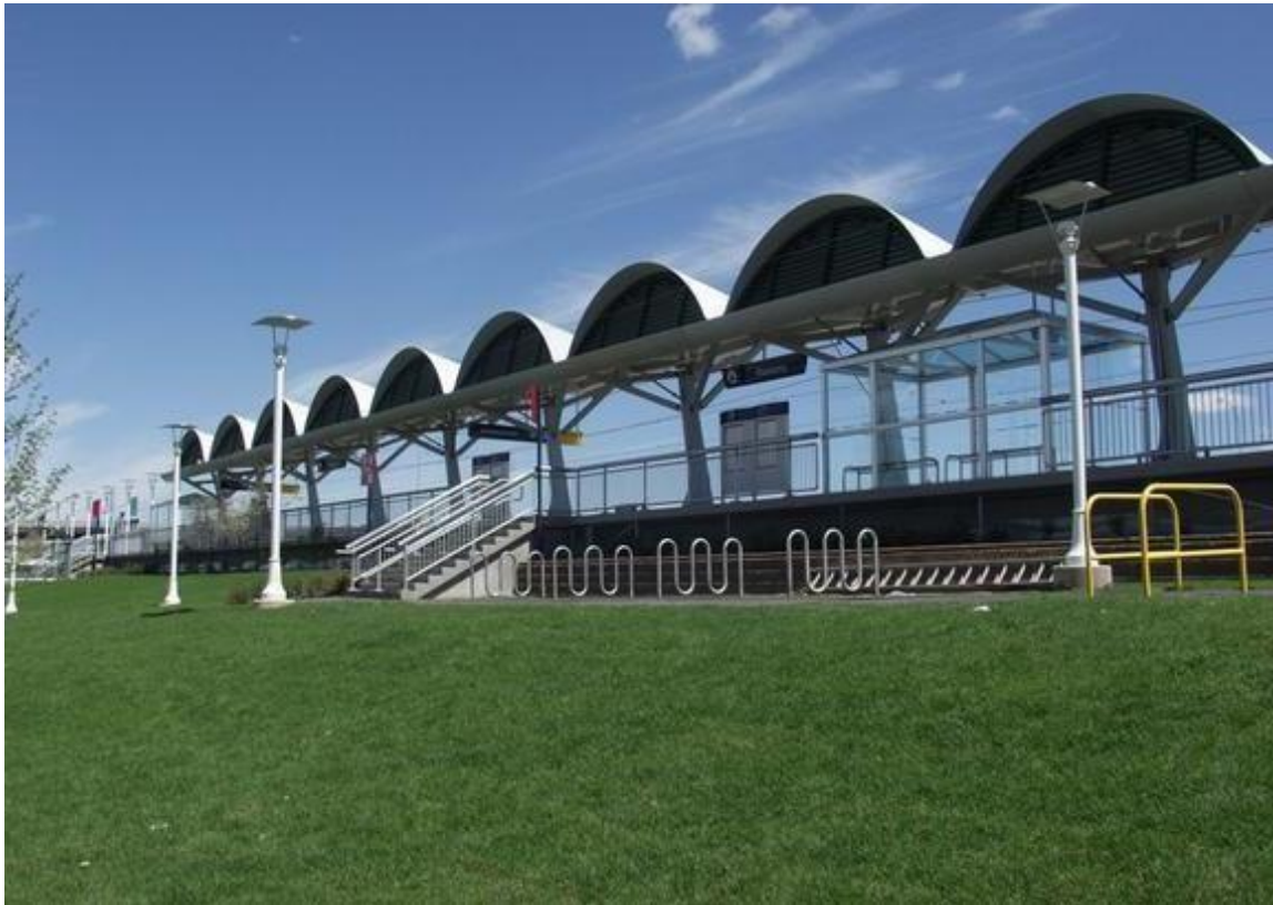
Figura 36. Estación de metro ligero de Shawnessy.
