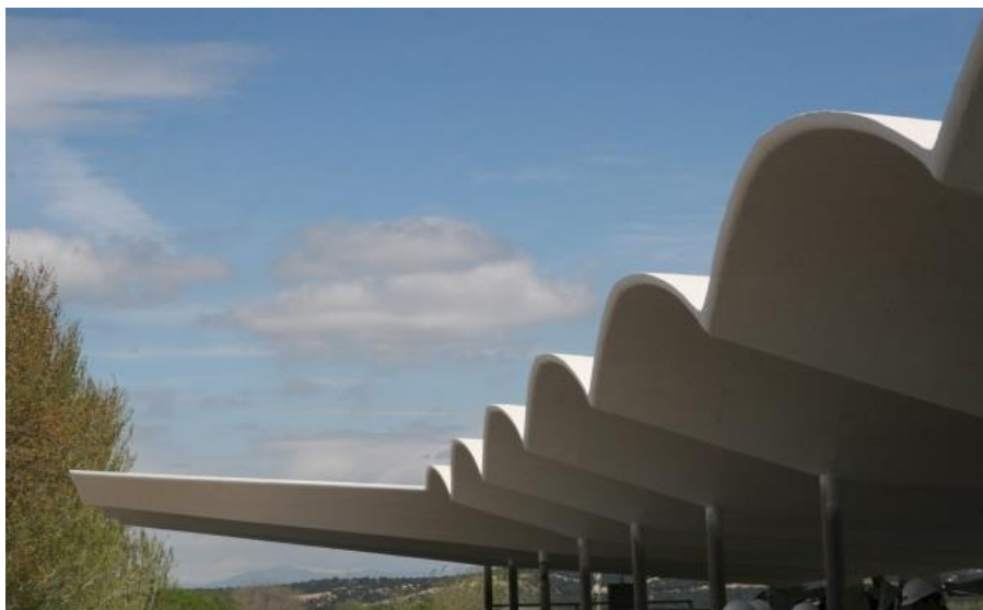
Figura 14. Cubierta del Hipódromo de la Zarzuela de Eduardo Torroja.
