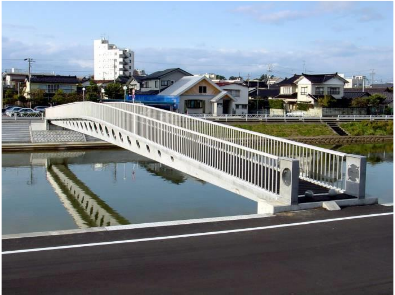
Figura 32, Puente sobre el río Niita en Sakata, Japón.
