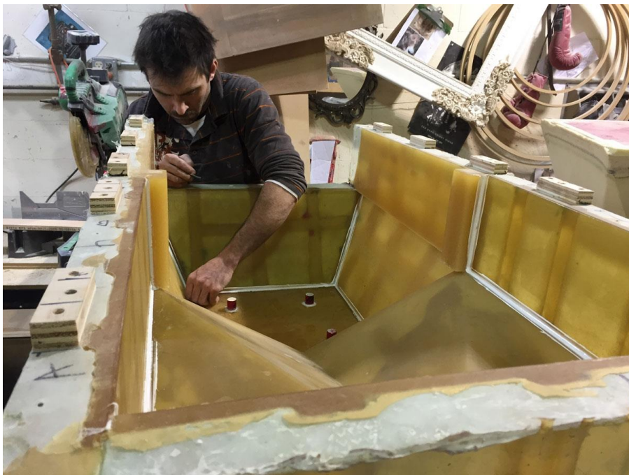
Figura 44. Uno de los moldes para la prefabricación de las piezas.
