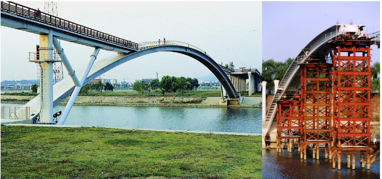
Figura 46. Puente Seonyugyo acabado y durante su construcción.
