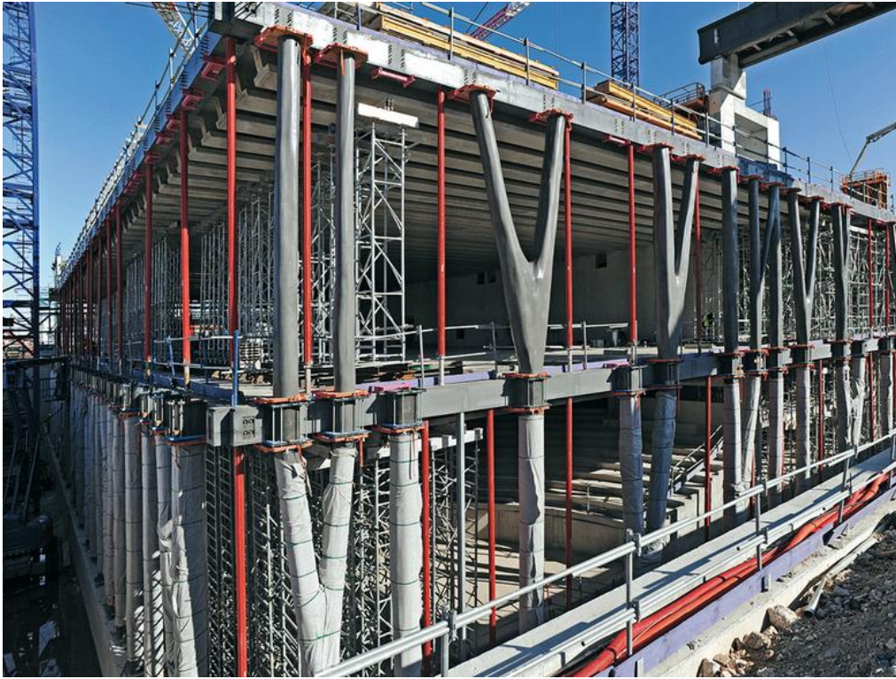
Figura 63. Construcción de la estructura del MuCEM.
