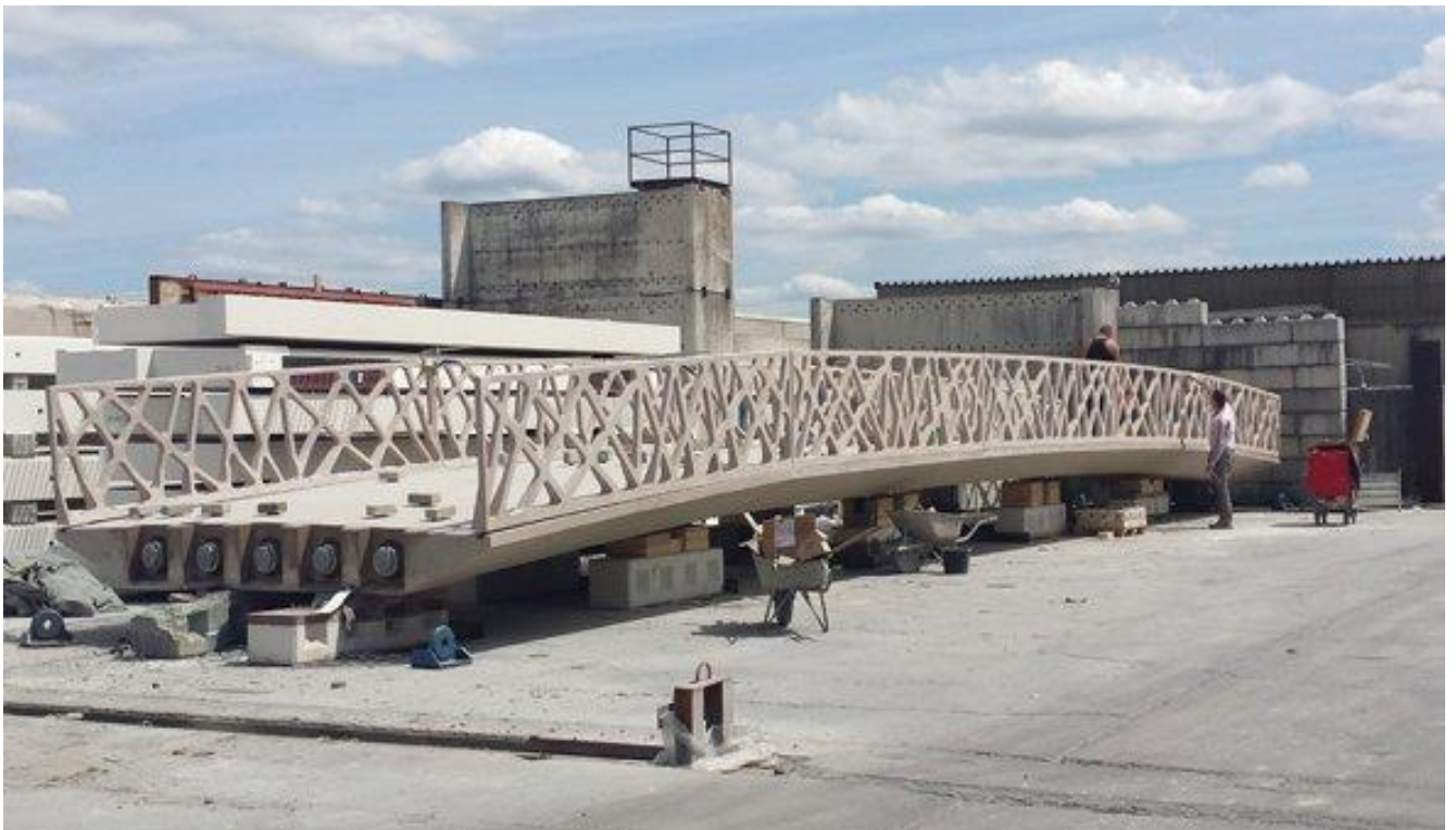
Figura 26. Puente prefabricado en Eindhoven.
