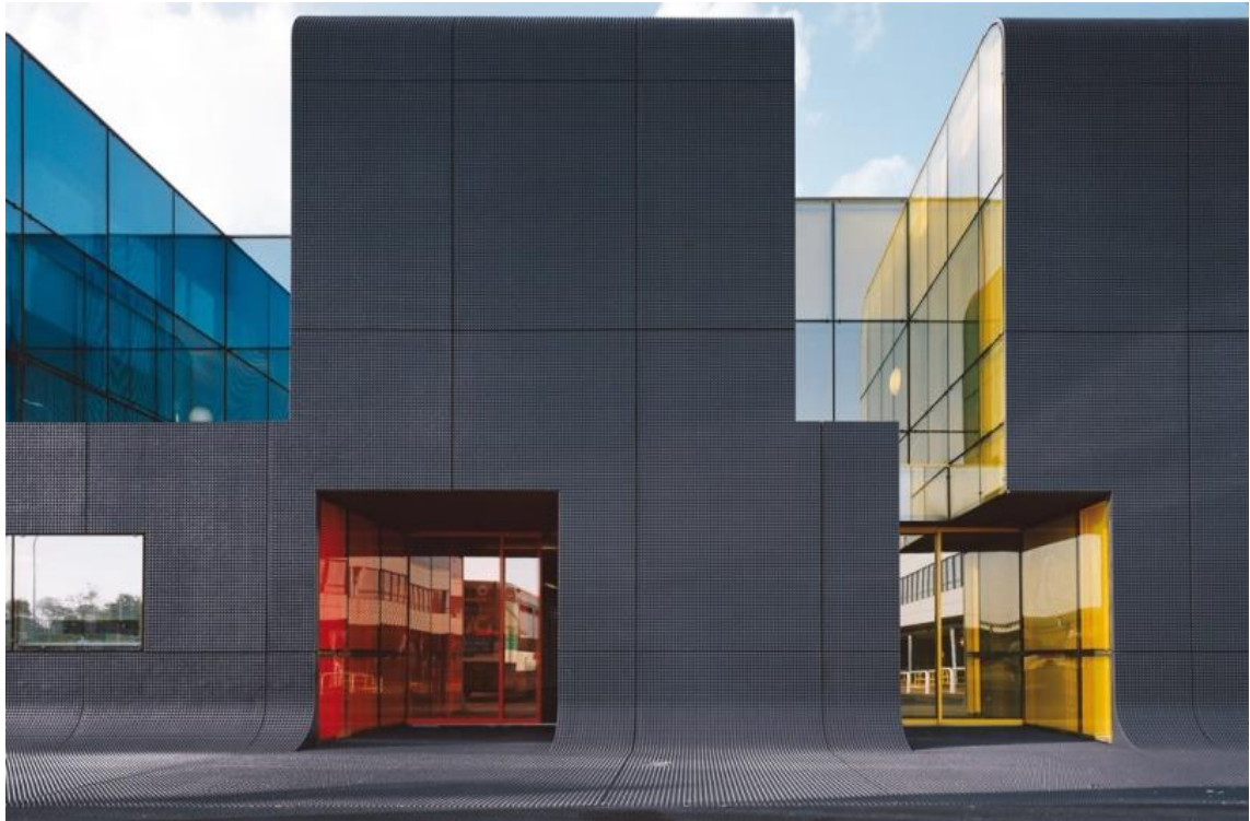
Figura 38: Estación de autobuses de Thais, Francia.
