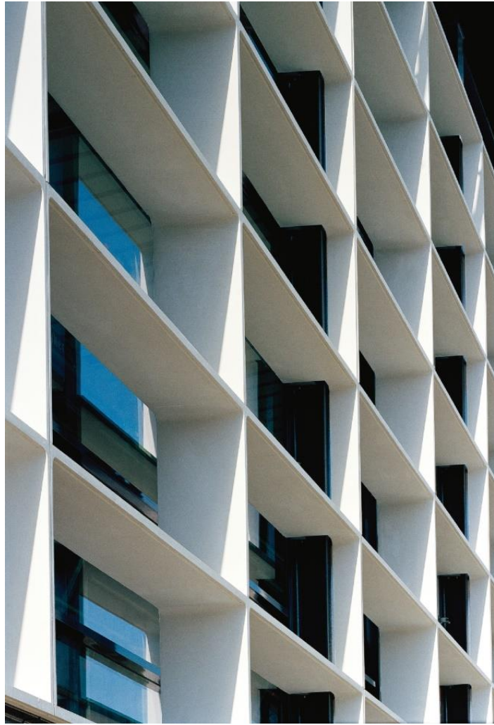
Figura 42. Detalle de la nueva fachada de la piscina municipal de Clichy, Francia.
