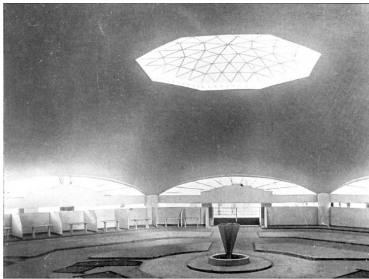
Figura 13. Cubierta del Mercado de Abastos en Algeciras.
