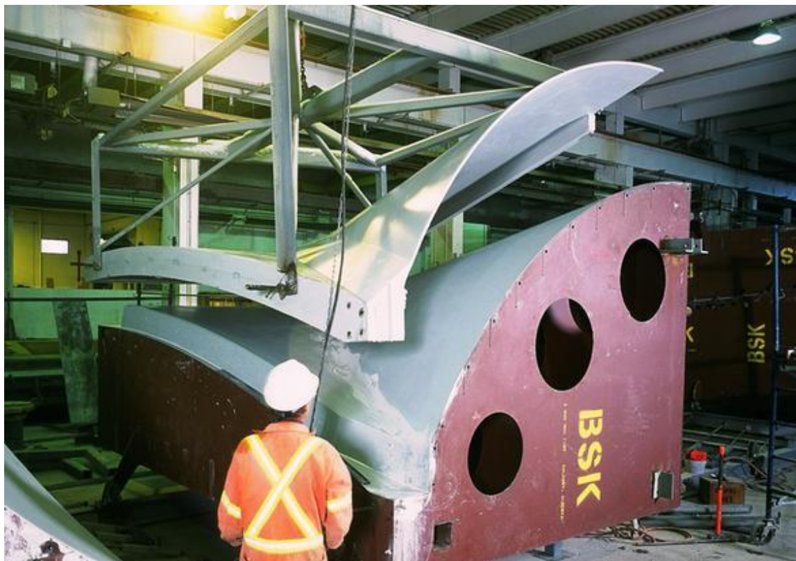
Figura 37. Molde para la prefabricación de la cubierta.
