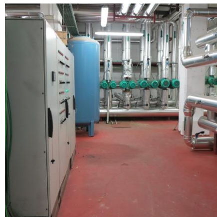
Fig 31. Segunda central. Armario, vaso de expansión y bombas
