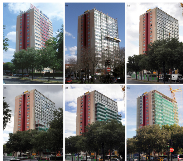
8.19 Proceso de construcción de la transformación de la Torre Bois-le-Prêtre.
