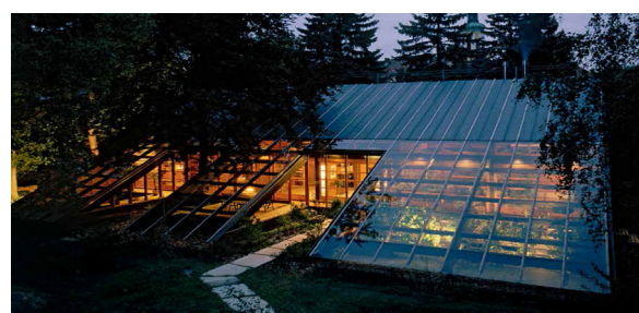
8.9 Cubierta inclinada acristalada Regensburg House, orientación Sur.
