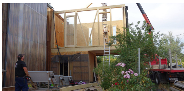
10.4 Proceso de construcción de la casa con paneles prefabricados realizados.
