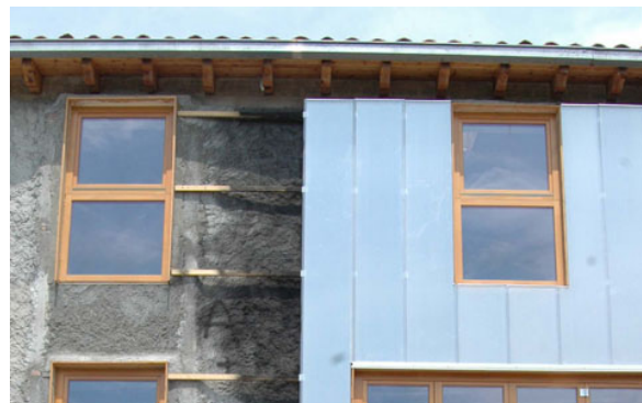
10.23 Policarbonato y muro existente pintado de negro.
