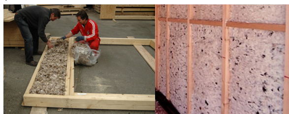
10.5 Montaje elementos prefabricados con aislante de lana de oveja natural.
