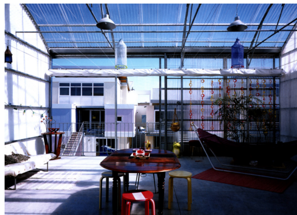
9.8 Interior de un espacio invernadero con toldos horizontales y cortinas térmicas para protección solar en verano.
