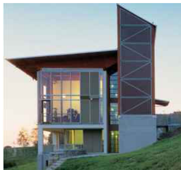
8.27 Fachada Este totalmente acristalada con persianas exteriores que protegen del Sol.
