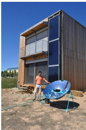
10.10 Fachada sur con placas solares mixtas.
