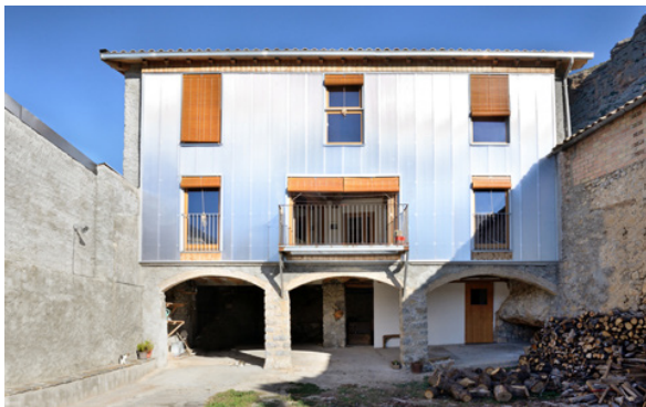
10.18 Fachada sur tras la rehabilitación, revestida de ocho capas de policarbonato.
