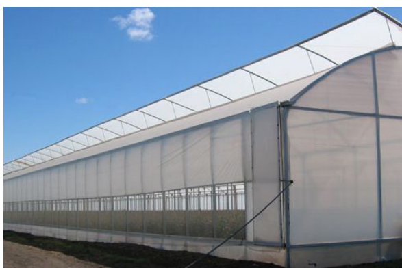
7.3 Ejemplo de invernadero con ventilación superior central.
