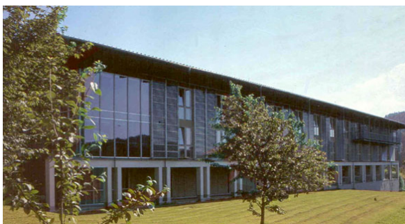
8.24 Fachada Sur compuesta por muros trombé y grandes ventanales.
