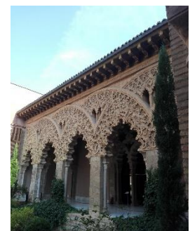
I 37: Pórtico Salas lado Sur
