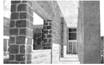
3.34- Guardería para la Olivetti. Detalle de las carpinterías de las aulas. E 1:100. Fuente: CSAC
