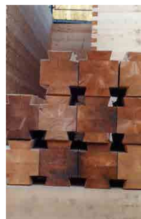
Fig.132 Montantes verticales con sección en forma de cola de milano para atar dos muros de bloques de madera. Proceso de obra antes de ser colocados en su posición.
