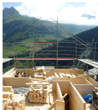
Fig.7,8 Sistema contemporáneo más común de esquina, gualdrapeado y mecanizado, con doble machihembrado
