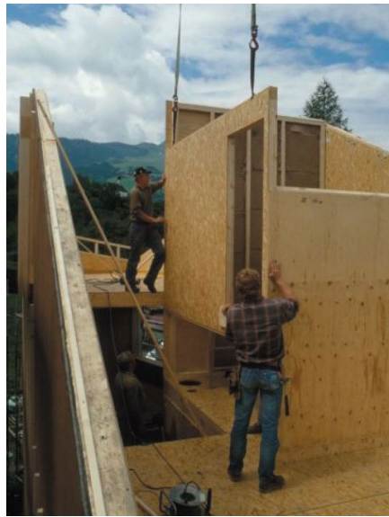
Fig.20 Montaje de las placas prefabricadas en la Casa Willmann-Lötscher (1998), Bearth&Deplazes
