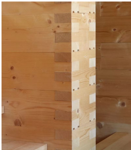
Fig.106 Stiva da morts (2002), Gion Caminada. Tipo de refuerzos necesarios al abrir huecos de cierta dimensión en un muro de bloques macizos de madera. Para evitar esta distorsión Zumthor desarrolla el sistema de torres.
