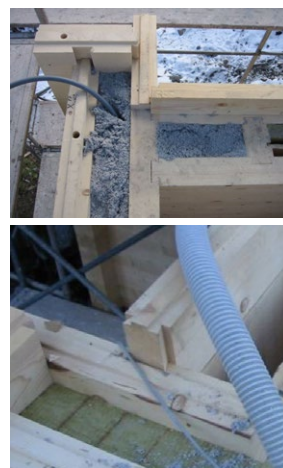
Fig.144, 145 Ejemplos de encuentros resueltos mediante “cola de milano” y relleno con aislamiento de doble muro de bloque de madera maciza. Stiva da morts (2002) Gion A. Caminada
