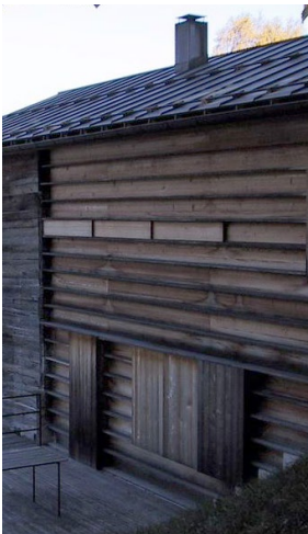
Fig.86 Detalle del sistema de cerrado del hueco mediante tableros correderos en el vano mayor junto a la puerta de acceso. Escala 1:20 Elaboración propia
