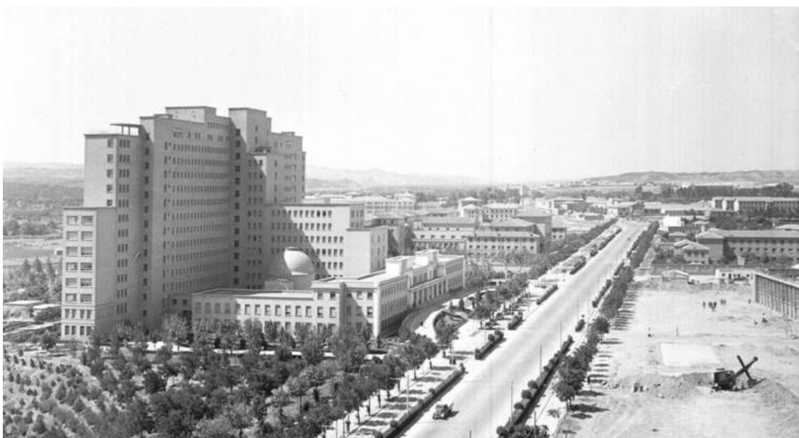
Fig. 4: Gran Hospital de Zaragoza una vez finalizada su construcción
