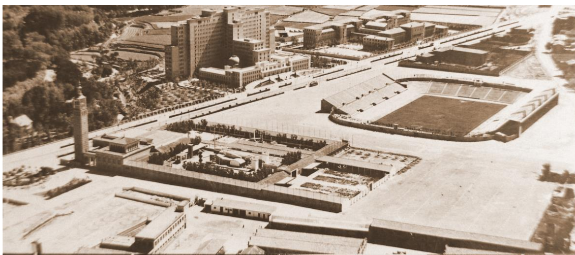
Fig. 7 Vista del emplazamiento del Hospital junto a la antigua Romareda y la zona de ferias.
