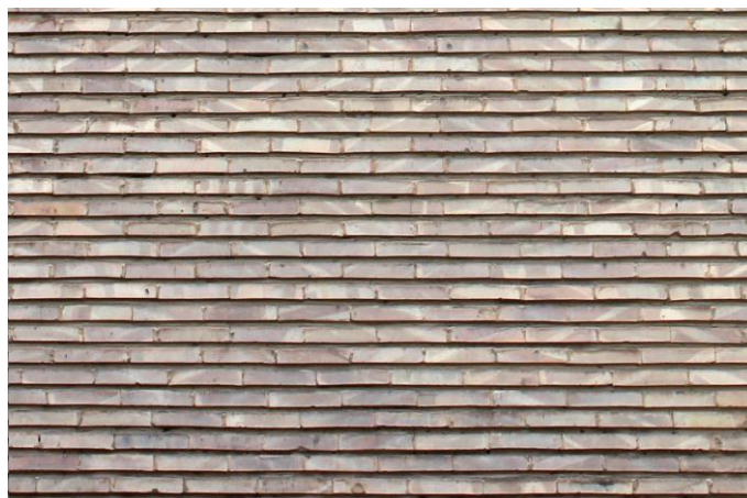
Fig. 19 Detalle del aspecto exterior de la fachada de ladrillo visto.
