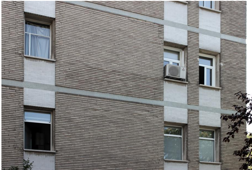
Fig. 30 Diferencia entre las carpinterías originales (piso superior) y las renovadas (piso inferior).
