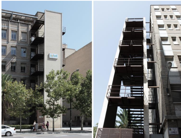
Fig. 44 Escalera de emergencia construida frente a la fachada principal.
