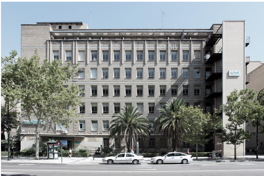
Fig. 18 Estado actual del alzado principal.
