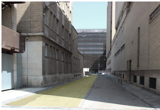
Fig. 46 Vista de la calle El Carmelo desde el Paseo María Agustín con la zona rellenada marcada.
