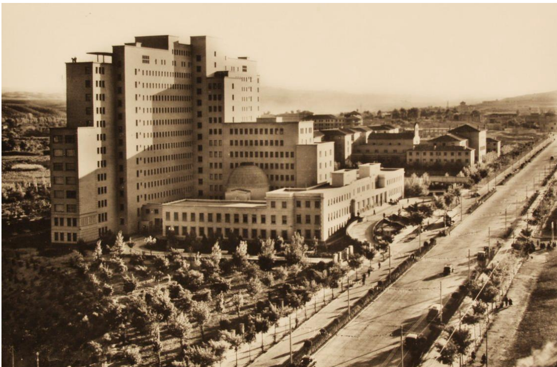
Fig. 8 Residencia Sanitaria José Antonio poco después de finalizar su construcción
