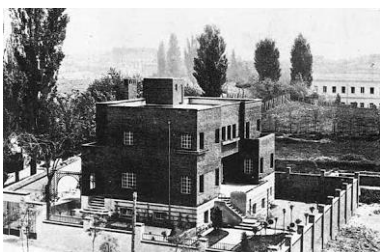
Fig 3. Casa del marqués de Villora, Rafael Bergamín, Madrid, 1927. Fuente: Carlos Flores
