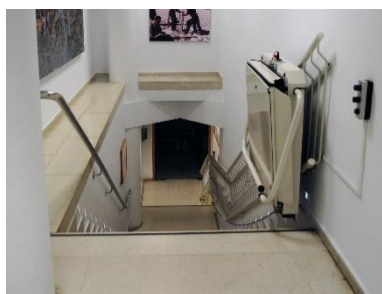
Fig 52. Silla salvaescalera para acceder al sótano en la parte de la ampliación de José Manuel Pérez Latorre. Fuente: Imagen propia
