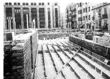
Fig 18. Ejecución de la cubierta plana, Zaragoza, 1938.
