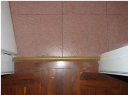
Fig. 90 Cambio del suelo de parquet a suelo de baldosa en aseo segunda planta
