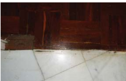
Fig. 47 Fotografía cambio de pavimento entre pasillo y sala.
