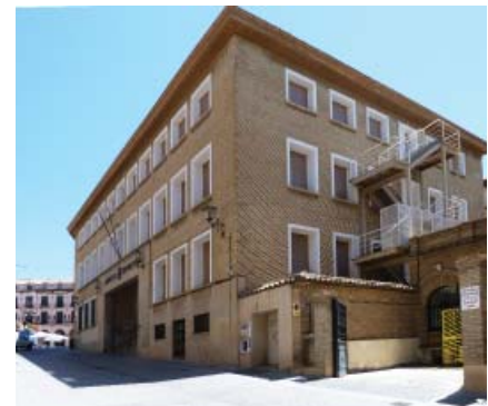
Fig. 32 Fotografía de la fachada
