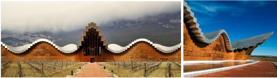
Imagen 11/12. Exterior de la Bodega Ysios. L. Alberto Ramos
