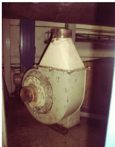
Figura A.I.4. Ventilador del transporte neumático
