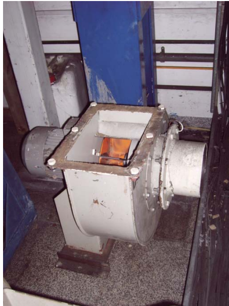
Figura A1.7. Ventilador de tiro forzado
