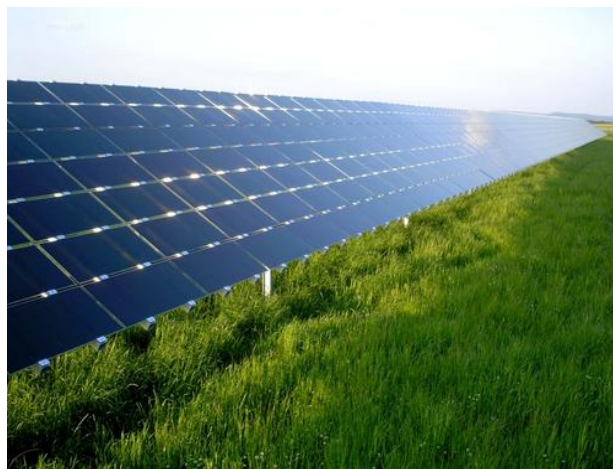
Figura 10. Panel solar fotovoltaico Thin film [10]
