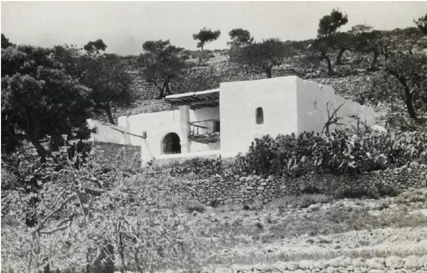
[79] Can Pujol, Ibiza. Fotografía de Raoul Hausmann. El alzado de la casa presenta un volúmen abierto, con una fuerte presencia del pilar en esquina y la cubierta con vuelo.
