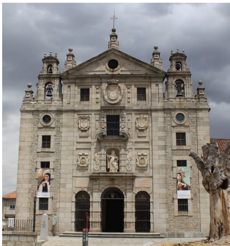
Imagen 2. Fachada de la iglesia del convento de Santa Teresa de Ávila, por fray Alonso de San José (1629-1636).
