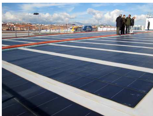
Figura 54. Paneles solares integrados en un edificio.
