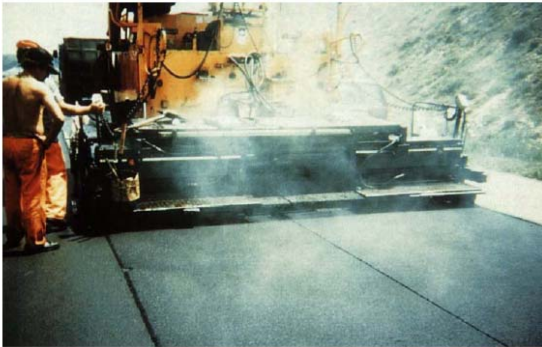
Imagen 2. Extensión de una capa de slurry sobre un firme en servicio
