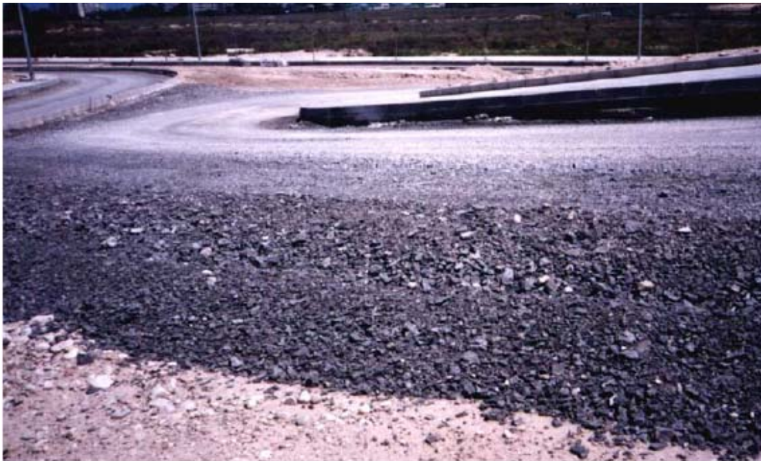
Imagen 5. Aspecto de la capa base puesta en obra
