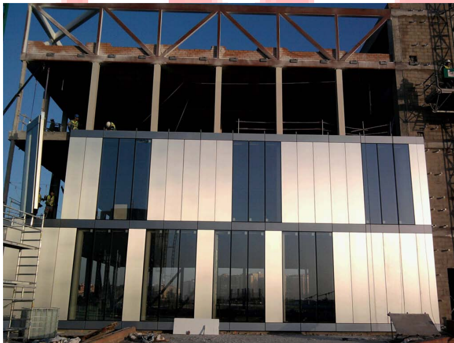
Figura 70: Edificio Centro Arte y Cultura de Zaragoza en proceso de montaje de su fachada con sistema Modular.
