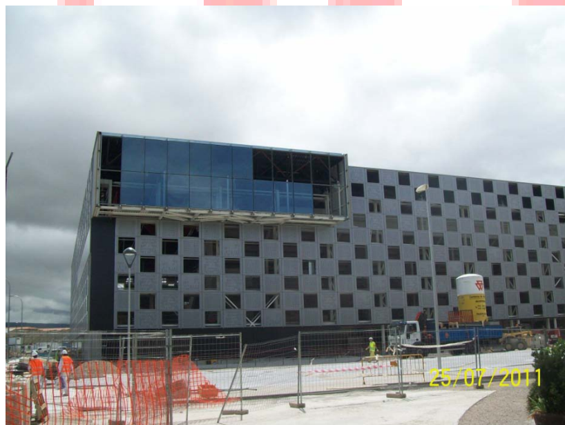
Figura 83: Obra realizada en muro cortina sistema stick previamente montados los montantes y travesaños y parcialmente acristalado.
