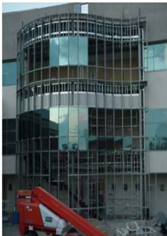
Figura 68: Edificio parcialmente acristalado con todo el sistema stick montado.
