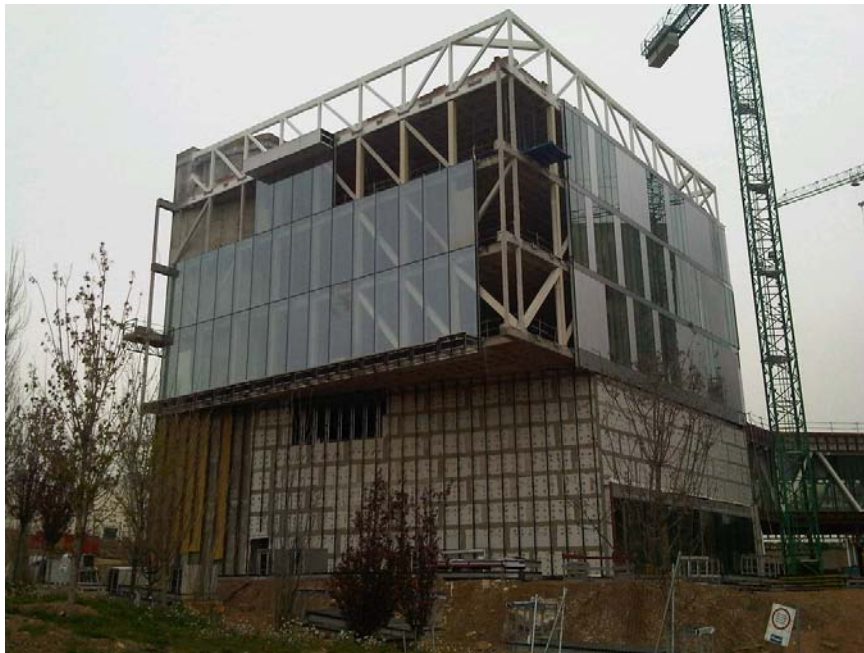
Figura 71: Imagen en la que se puede apreciar la secuencia de montaje en el sistema modular.
