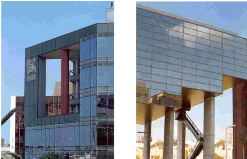
Figura 69: Obras acristaladas con sistema Stick.
