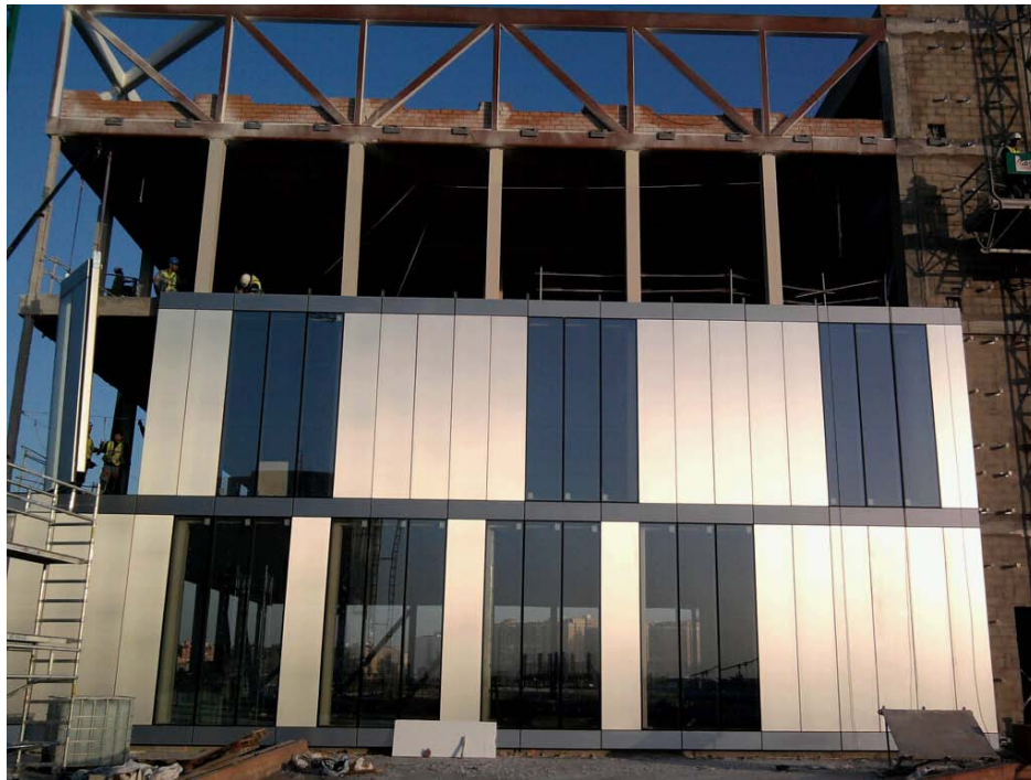
Figura 84: Foto realizada en el montaje de muro cortina sistema modular en el Centro de Arte y Cultura de Zaragoza.
