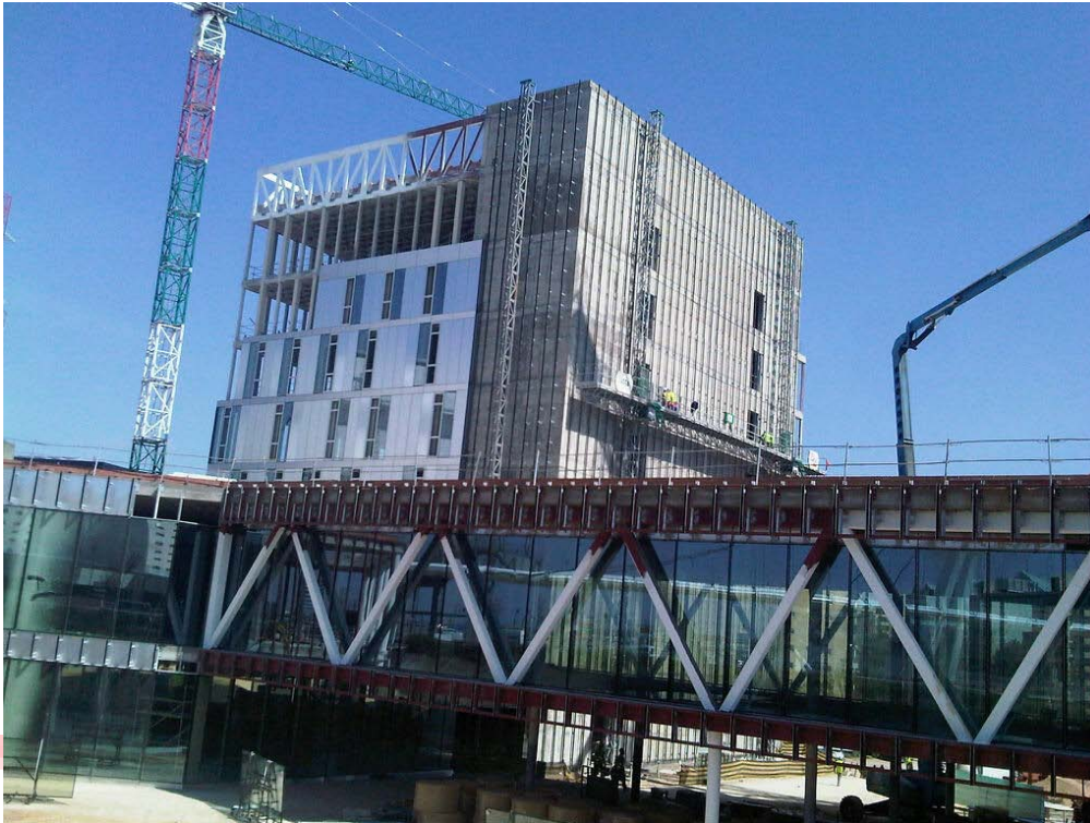
Figura 72: Centro del Arte y Cultura de Zaragoza en el que se ven zonas realizadas con el sistema modular y otras con el sistema stick.
