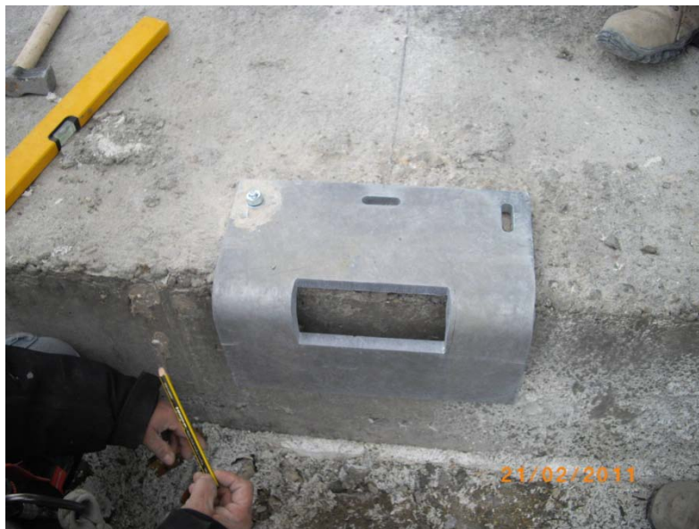
Figura 82: Anclaje replanteado y montado para el sistema modular.
