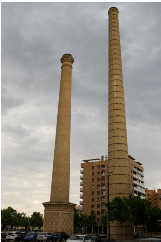
Fig. 15. Columna con base cuadrada y columna con cellos metálicos
