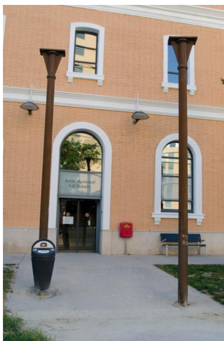
Fig. 8. Columnas de fundición
