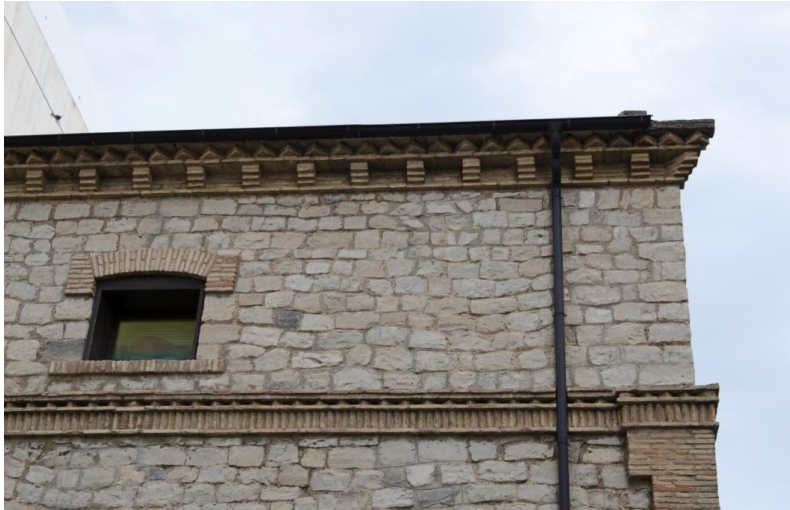
Fig. 40. Detalles en ladrillo: esquinas, ventanas, molduras...
