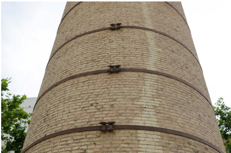
Fig. 47. Chimenea con sección circular y con cellos metálicos
