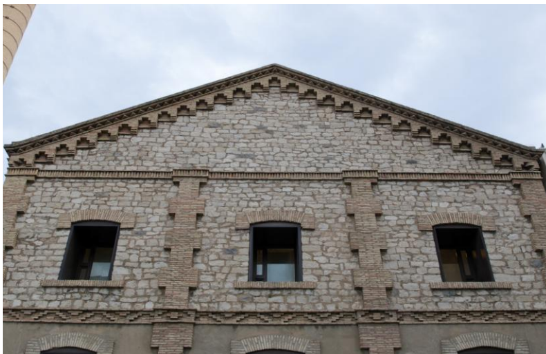
Fig. 42. Detalles en mampostería y ladrillo
