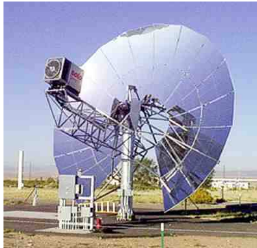
Figura 7. Dispositivo disco Stirling de 10 kWe. Alemania.
