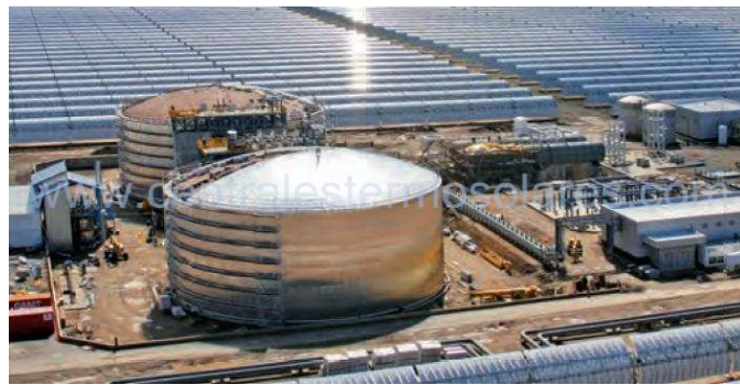
Figura 14. Sistema almacenamiento térmico Gemasolar
