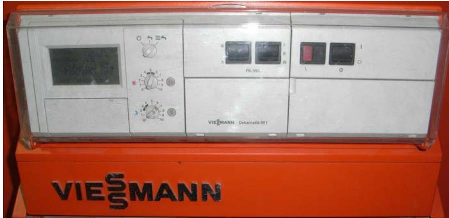
Figura 22 - Controladora Dekamatik M1
