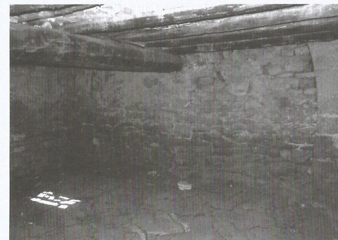
Figura 8. Arranque del arco apuntado cegado en la planta baja de la torre Torre Camañes —Cantavieja—. (Fotografía de Beatriz Martín Domínguez)
