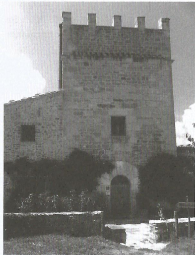
Figura 3. Fachada principal de Torre Monte Santo —Villarluengo—, en la que destaca la calidad en la talla de los huecos y del escudo que presenta sobre la puerta de acceso principal. (Fotografía de Beatriz Martín Domínguez)
