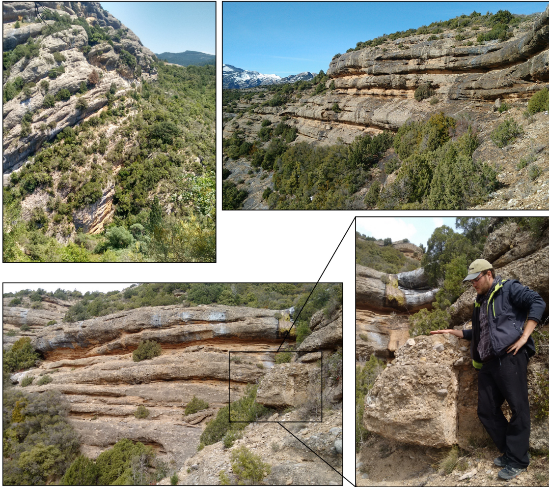
Figura 11: Aspecto en afloramiento de la litofacies CA, en la que se aprecian la aparente geometría tabular, pero también los acuñaientos laterales, intercalaciones areniscosas, y variabilidad granulométrica.
