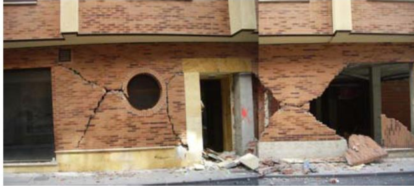
Fig 3: Daños por cortante en cerramiento no estructural
