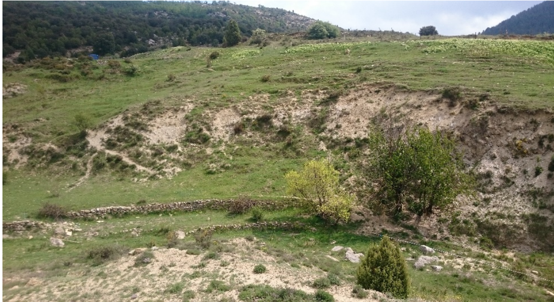
Figura 16. Medidas estructurales de contención de deslizamientos preexistentes, estas medidas consisten en muros de escollera contruidos a base de mampostería de caliza seca en aterrazamientos. El impacto visual que ejercen sobre el paisaje es mínimo.
