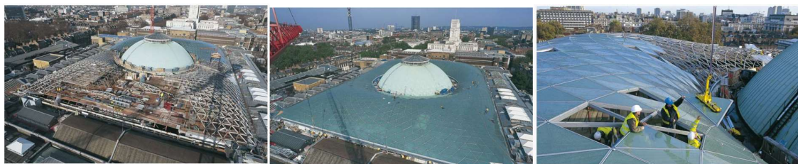
Figura 44. Proceso constructivo de la cúpula del Great Court.
