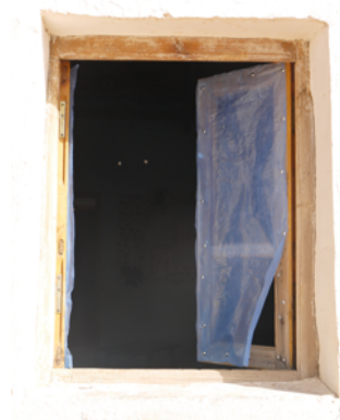
Foto A I-3: ventana de madera con el cristal roto, en su lugar se colocó un plástico traslucido
