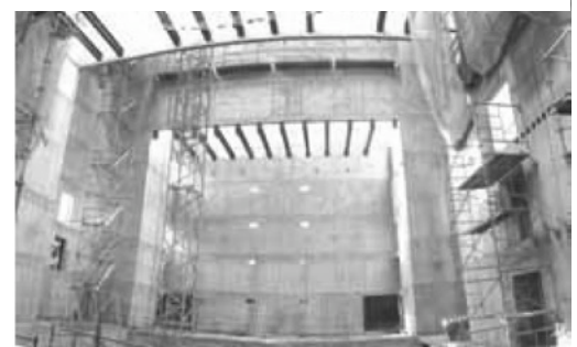
Fig. 159 Celosías mixtas de gran canto en obra.
