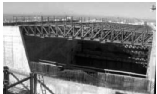
Fig. 160 Celosías mixtas vistas desde cubierta.
