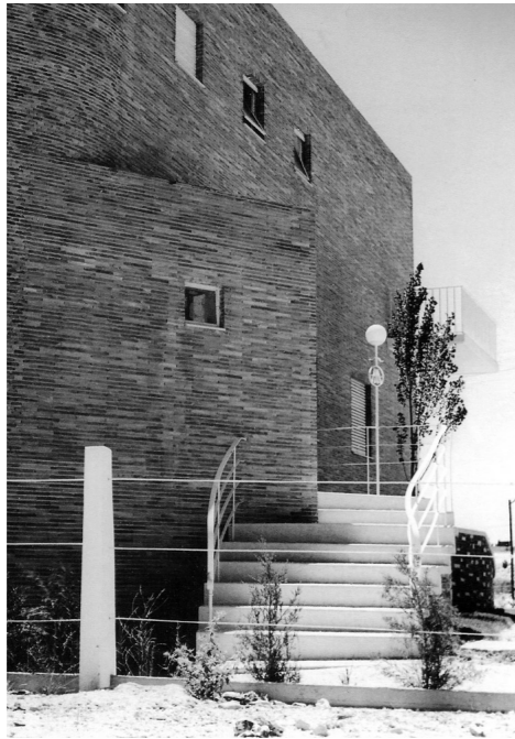
[53]: Escalera exterior Casa Doctor Arce, 1955
