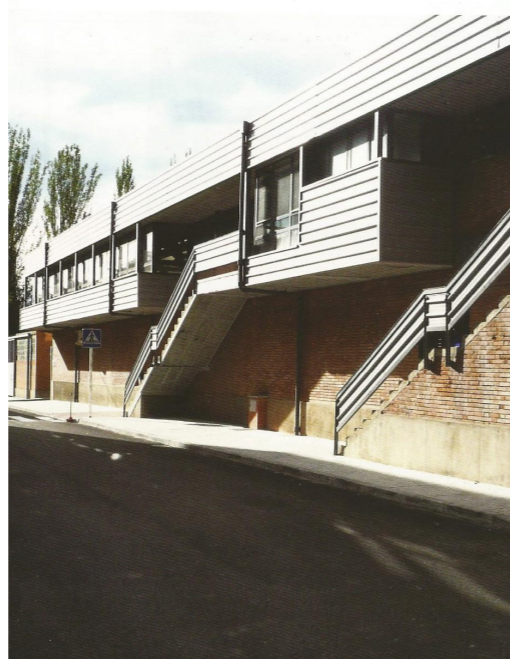
[67]: Escalera en fachada del edificio comedor del CENIM, 1963
