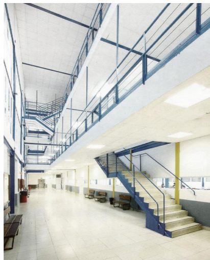
[91]: Escalera interior Aulario y seminarios para la Universidad de Sevilla, 1972
