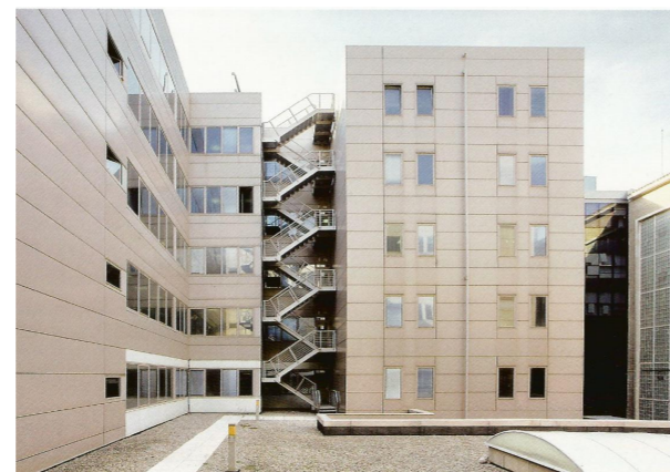
[102]: Escalera de emergencia de la ampliación de los Juzgados de Zaragoza, 1986
