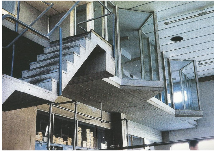
[68]: Escalera interior abierta al espacio de trabajo de la Central Lechera Clesa, 1957
