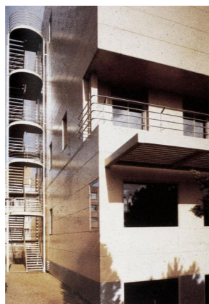
[101]: Escalera de emergencia del Edificio de Correos de León, 1984
