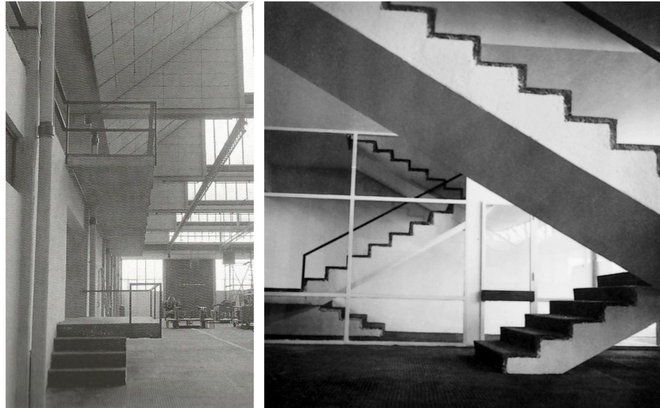
Vista interior Escalera 2
