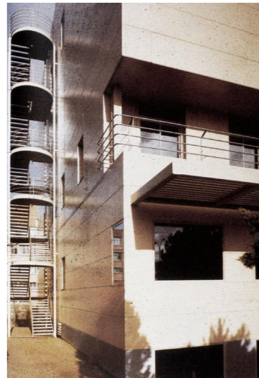
Vista interior escalera 1
