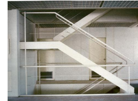
Vista interior escalera 1
