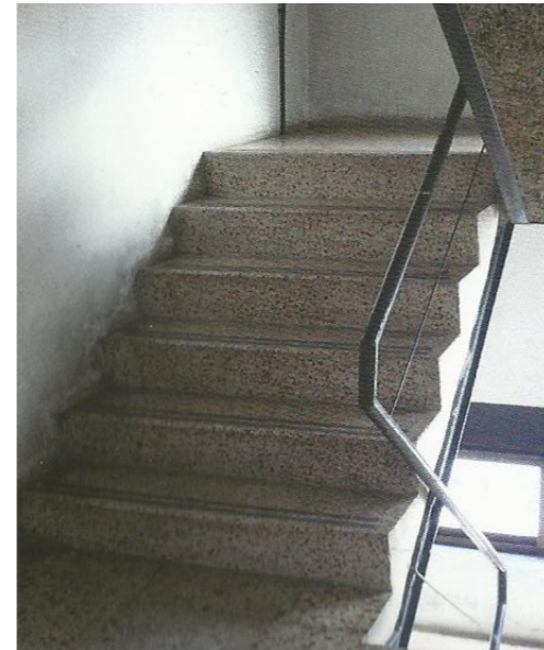
Vista exterior Escalera 2, nave
