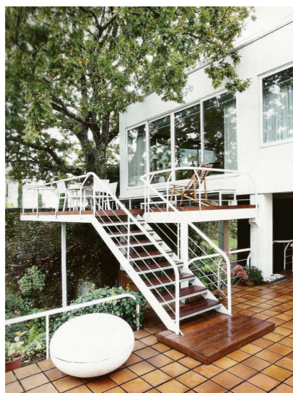
[94]: Escalera exterior de la Casa Dom6nguez, 1973
