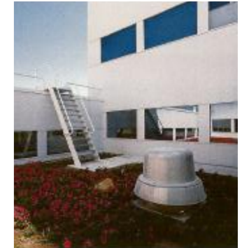
Vista exterior escalera 2
