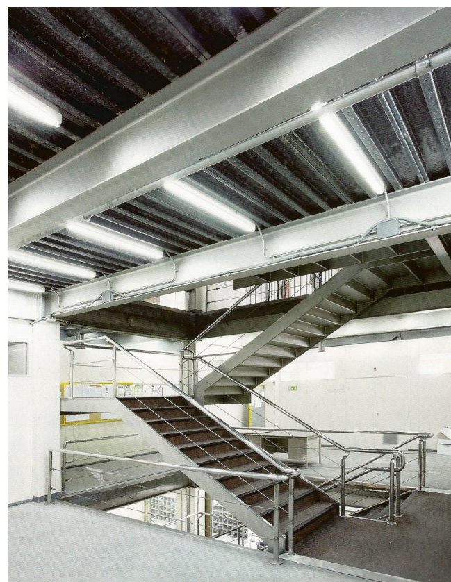
[86]: Escalera interior del Edificio de Correos de Le3n, 1981
