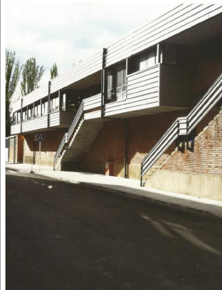
Vista exterior Escalera 1, edificio comedor
