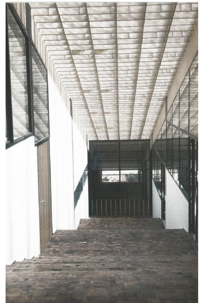
Vista exterior de la Escalera 1
