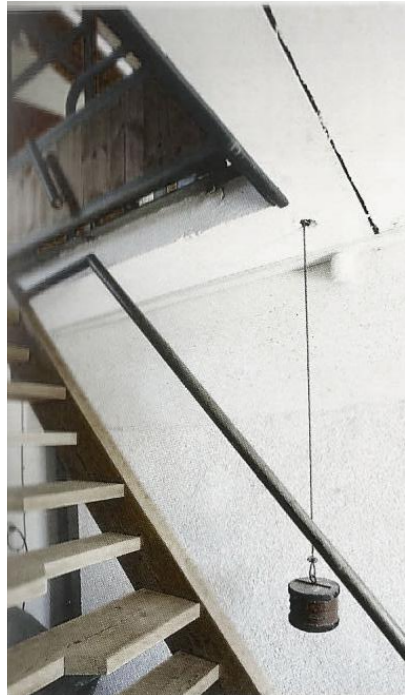
[78]: Vista interior de la escalera de samba de la Casa Varela, 1964
