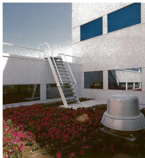
[95]: Escalera exterior de acceso a la cubierta del Centro de C6lculo, 1972
