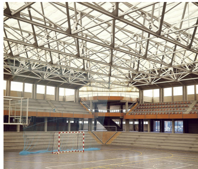
[62]: Interior del Pabellón Municipal de Pontevedra, 1965
