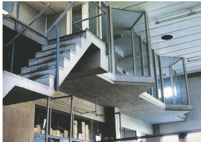
Vista interior Escalera 3 desde la nave de trabajo
