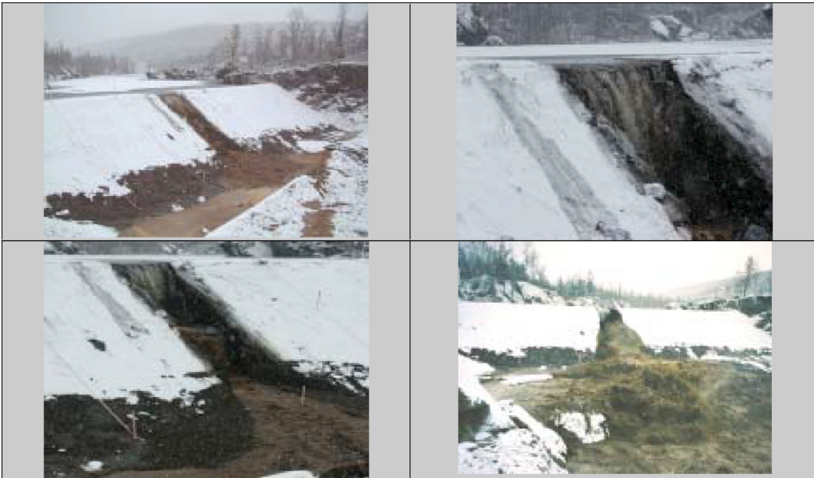
Figura 4.11: Imágenes de la evolución de la brecha en el caso real de desbordamiento.
