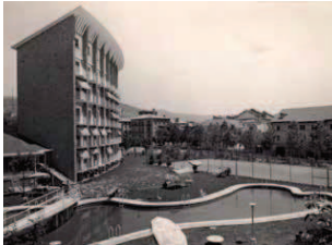
Figura 08. Vista exterior de las instalaciones del Gran Hotel de Jaca.
