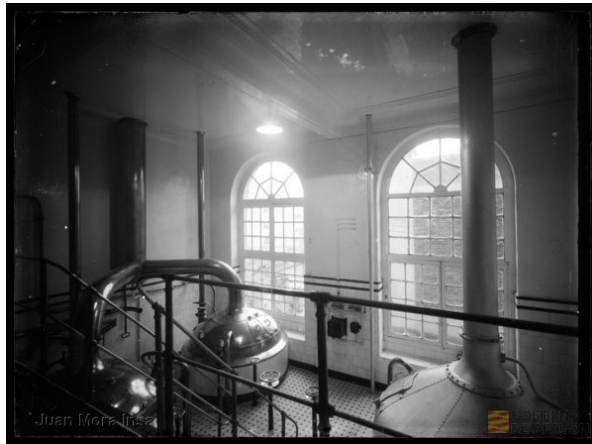
Fig.5 Sala de cocidas (Estado actual). Las calderas de cobre han quedado en desuso y forman parte del Museo de la Cerveza. Las nuevas calderas, de acero inoxidable, se localizan enfrente.
