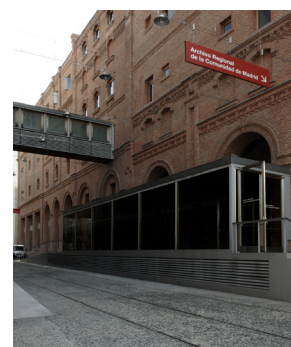
Fig.117 Situación de las rejillas de acceso del aire exterior a tratar.
