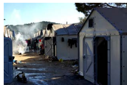
Fig.66 Falta de adaptación de las unidades de vivienda de Moria al terreno.
