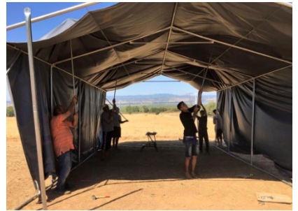
Fig.37 Proceso de montaje de aulas.
