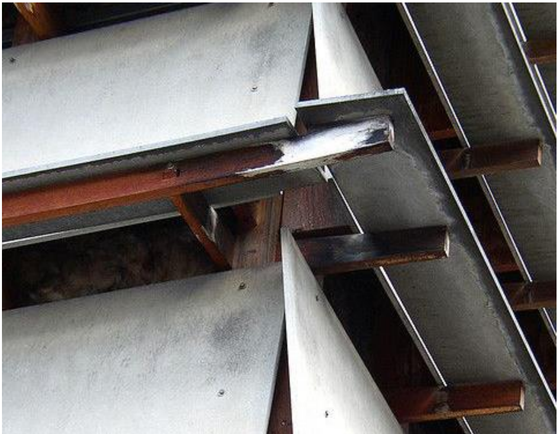
Fig. 49. En el detalle en esquina se observa el ensamblaje entre los paneles y la estructura de madera. A través del entramado se intuye el material aislante, permeabilidad en la piel imperceptible desde lejos.
