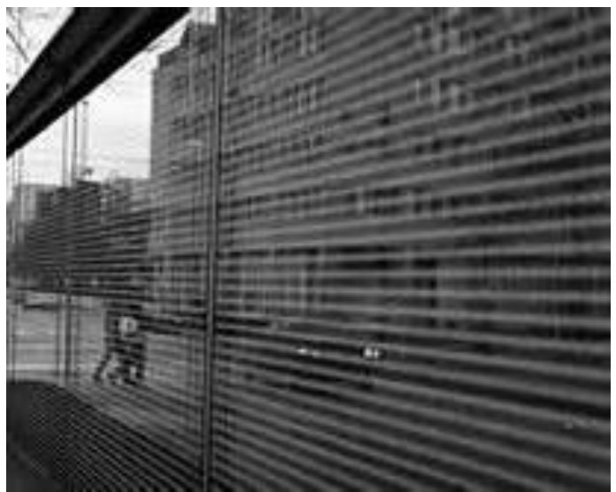
Fig. 54-55. La piel de vidrio recibe distintos tratamientos: serigrafiados, materiales aislantes vistos y tecnologías avanzadas definen un revestimiento versátil.
