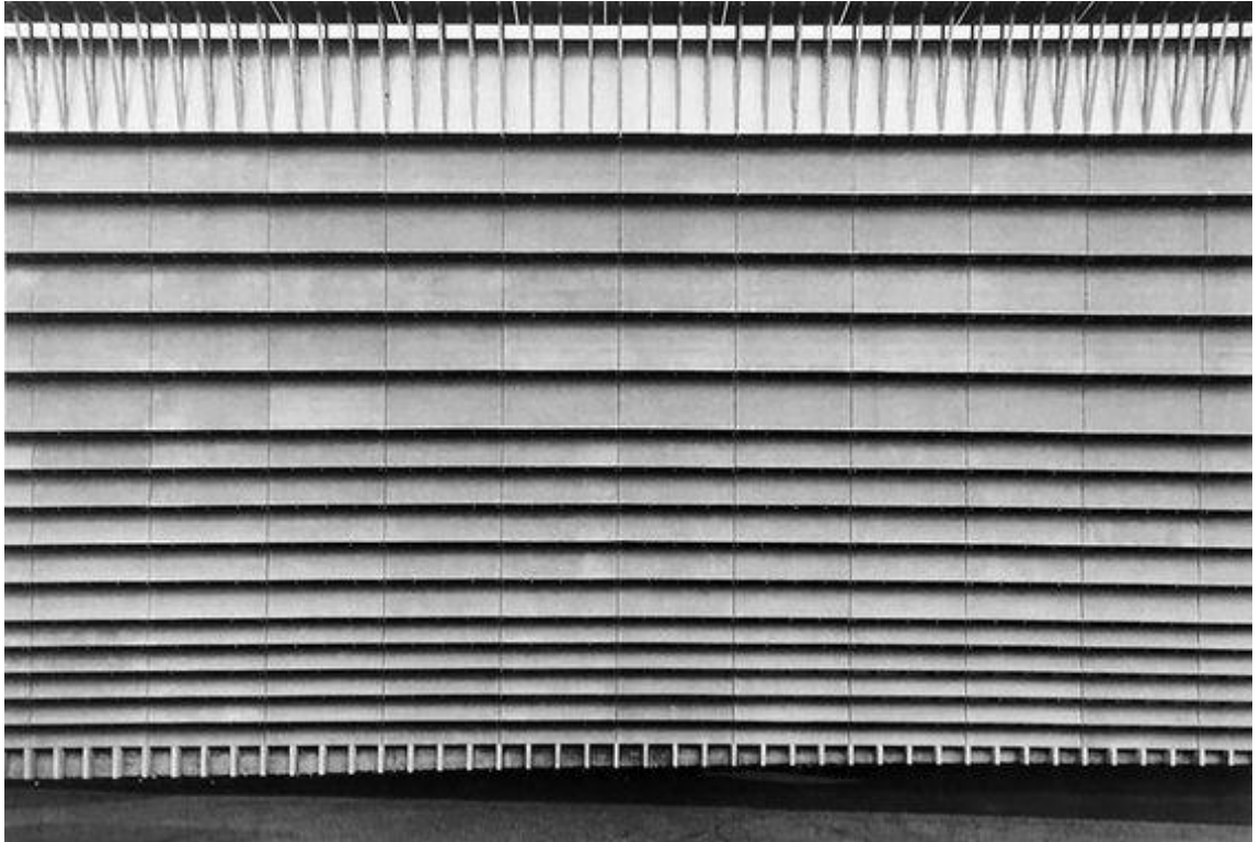
Fig. 46. La fachada es forma y es estructura. El tamaño de los paneles varía para producir sensación de peso en la base frente a la ligereza de la cubierta. La superposición de múltiples elementos conforma una única unidad donde “la percepción de su adhesión se reduce a cero”.
