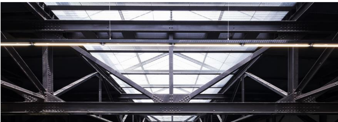
Fig. 10. La estructura metálica soporta el sistema que ilumina las salas durante el día. Por la noche se invierten los papeles: la luz interior se refleja en el lucernario y se observa como punto de referencia junto al Támesis.
