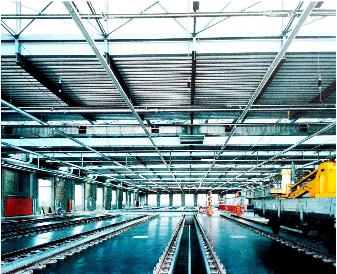
Fig. 33. La entrada de luz en el depósito desmaterializa la estructura del lucernario, ocultando la verdadera estructura portante. La presencia de vigas que no apoyan en ningún pilar enfatiza esta confusión visual.
