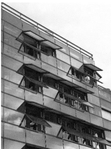
Fig. 54-55. La piel de vidrio recibe distintos tratamientos: serigrafiados, materiales aislantes vistos y tecnologías avanzadas definen un revestimiento versátil.
