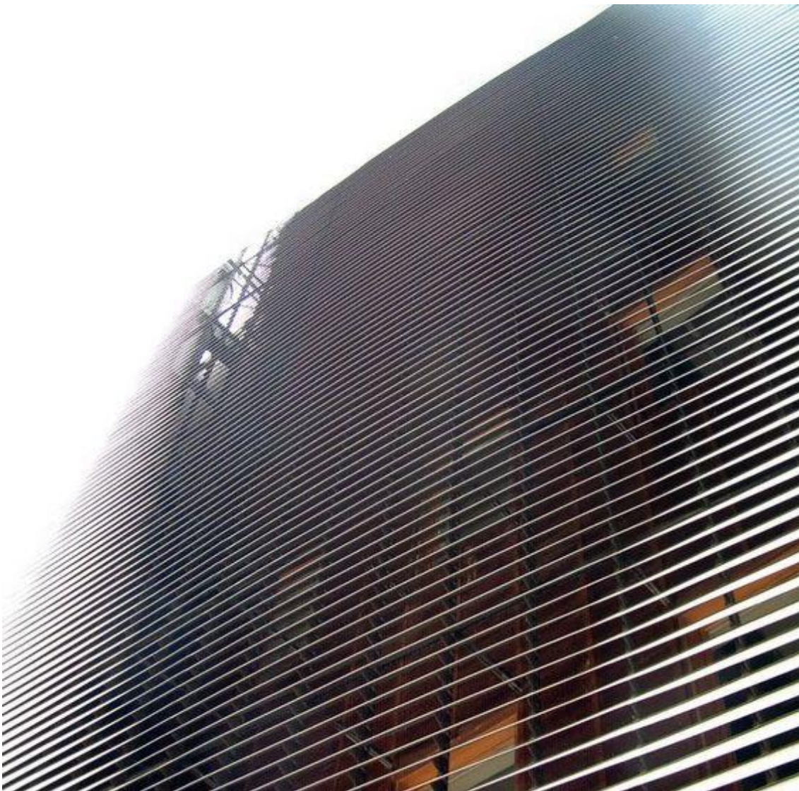
Fig. 52. La piel se compone de unas tiras metálicas a través de las cuales se visualiza el interior. La sensación es la de un revestimiento que cubre un edificio ya construido.
