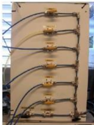
Figura A. 8: Panel de válvulas. Instalación de oxidación de sulfuro de hidrógeno.
