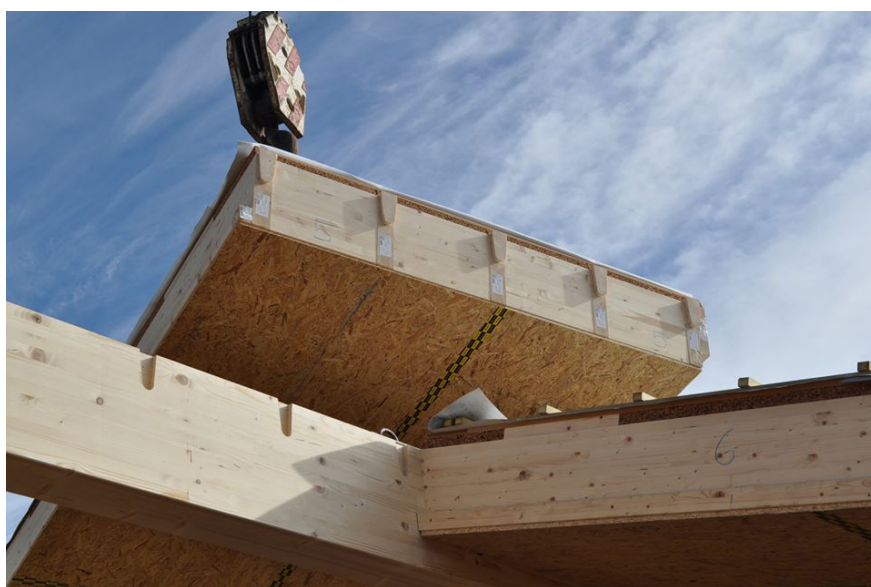
Fig. 67_Colocación del panel prefabricado de cubierta. Detalle de los engastes en paneles y viga de cumbrera para perfecto anclaje ( https://www.facebook.com )
