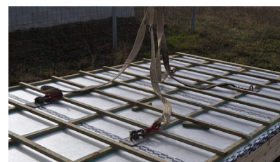
Fig. 70_Subestructura mediante rastreles para colocación de tejas ( https://www.facebook.com )
