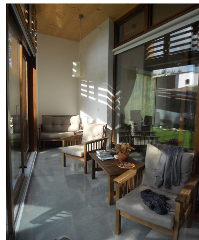
Fig. 113_Galería a sur. Estor en carpintería interna para evitar la incidencia solar indeseada al interior de la vivienda ( https://estudioduqueyzamora.com )
