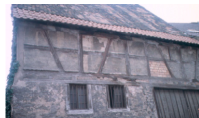
Fig. 15_Ejemplo de vivienda mediante el sistema “Stabbauweise” (Jacobo, 2004)
