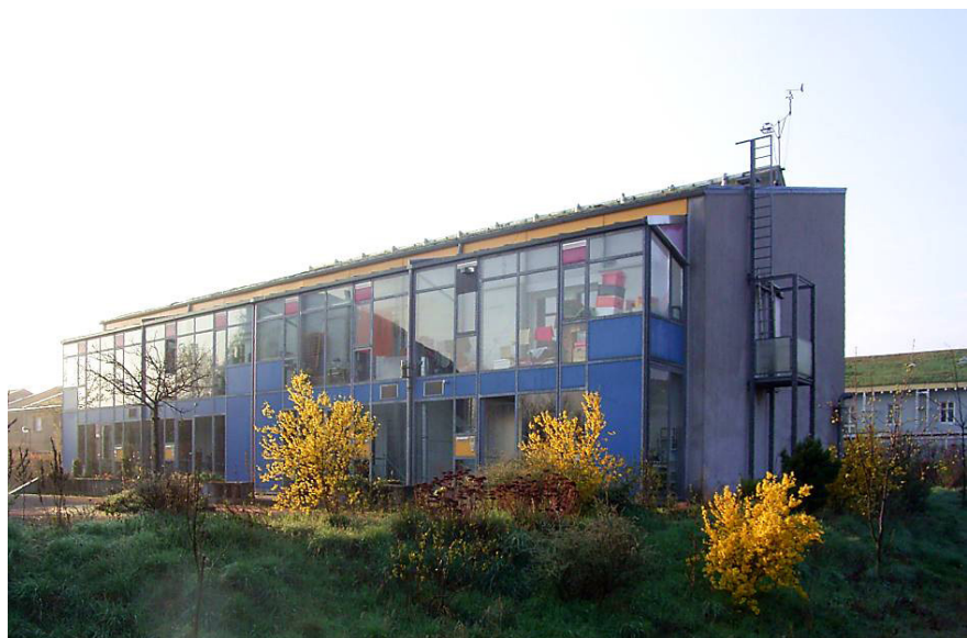
Fig. 36_Fachada norte. Galería acristalada. Captación solar por cubierta, precalentando el aire de acceso al interior a través del intercambiador ( http://passiv.de ).
