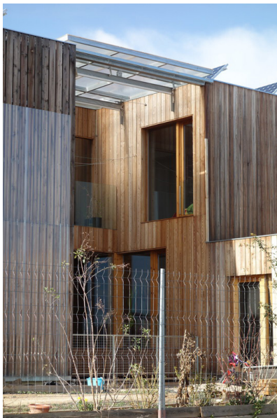
Fig. 110_Cubierta vidriada cerrando el espacio interior (https://www.plataforma-pep.org)
