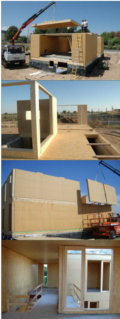
Fig. 65_Montaje de paneles de entramado ligero prefabricados para la vivienda Bunyesc (Bunyesc, 2009).
