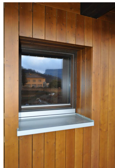
Fig. 99_Incorporación de lámina de aluminio en vierteaguas para proteger la carpintería ( https://www.facebook.com )
