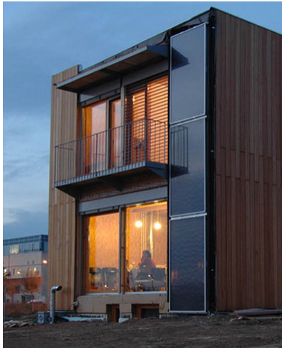
Fig. 109_Fachada sur. Protección solar mediante alero y lamas (https://www.plataforma-pep.org)
