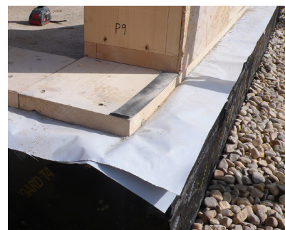
Fig. 77_Sellado hermético en montaje de los paneles prefabricados. Rivas Passivhaus (Natural Concept, 2015)
