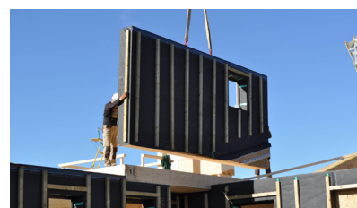
Fig. 49-55_Proceso construcción y montaje de los paneles de entramado pesado prefabricado, vivienda Estrella dels Vents ( http://www.facebook.com )
