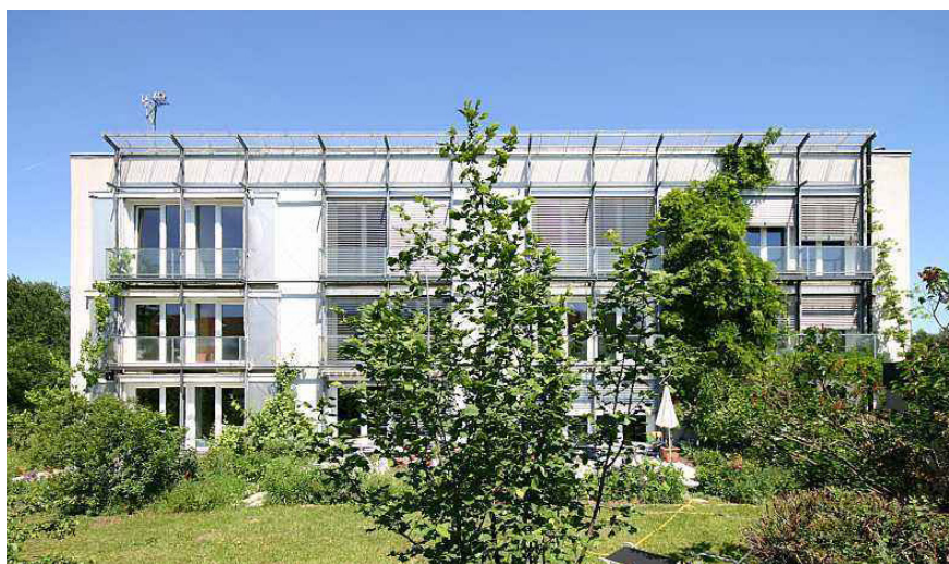
Fig. 32_Fachada sur. Aleros y persianas exteriores venecianas para evitar ganancias solares indeseadas ( http://passiv.de ).
