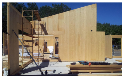
Fig. 56_Esquema envolvente mediante paneles contralaminados (KLH, 2013)
