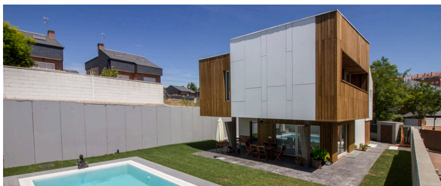
Fig. 106_ Exterior Rivas Passivhaus. Protección solar mediante el retranqueo de la geometría. ( https://www.plataforma-pep.org )
