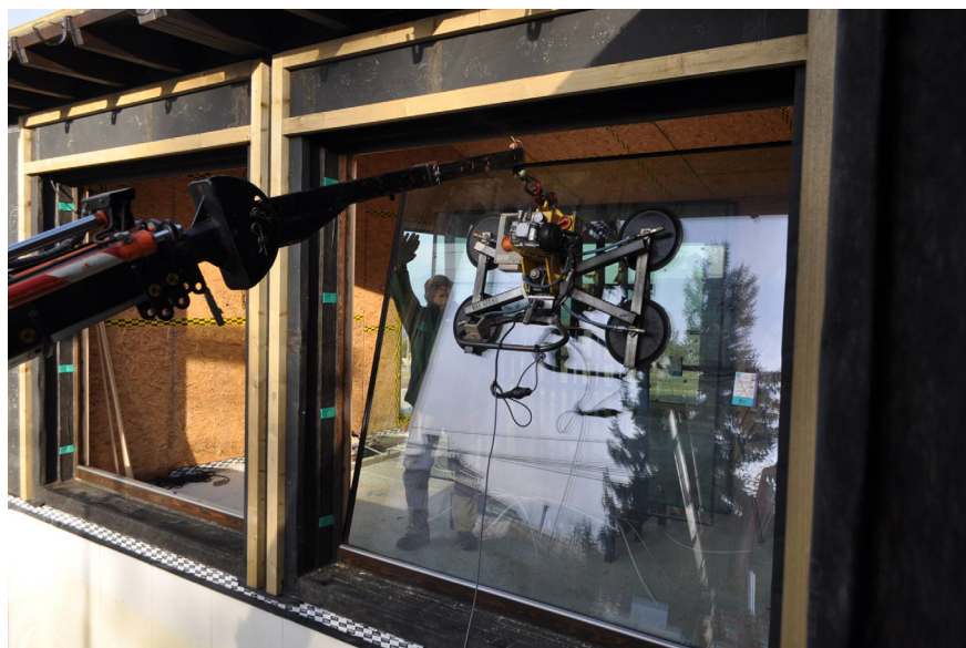
Fig. 100_Colocación de los vidrios en las carpinterías ya ancladas a la envolvente ( https://www.facebook.com )
