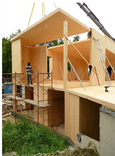
Fig. 73_Montaje cubierta vivienda EntreEncinas ( https://estudioduqueyamora.com )
