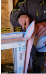
Fig. 78_Instalación de bandas herméticas en carpintería previa a colocación en pared (Natural Concept, 2015)
