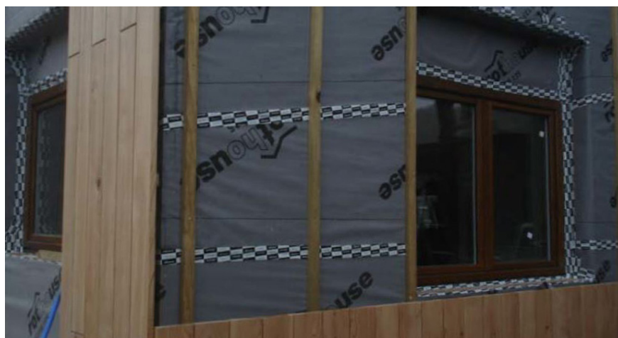
Fig. 95_Ventanas instaladas en la envoltorio. Selladas mediante bandas a interior y exterior para conseguir la mayor hermeticidad. Retranqueadas de la fachada para protegerse del sol y las inclemencias atmosféricas. ( https://www.construction21.org )
