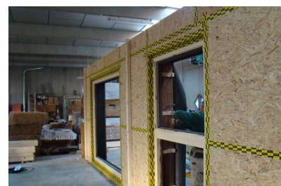
Fig. 98_Montaje de carpinterías en el panel prefabricado en taller ( https://www.facebook.com )
