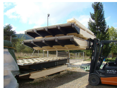
Fig. 83_Paneles prefabricados de cubierta, vivienda Estrella dels Vents. Tratamiento y tinto de la madera solo a la parte que permanece al exterior en el conjunto ( https://www.facebook.com )
