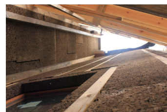
Fig. 90_Paneles de corcho en fachada. Rastrelado en capa exterior para anclaje de fachada ventilada. ( http://casaentreencinas.blogspot.com.es )
