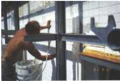
Fig. 34_Estructura para protección solar ( http://passiv.de ).
