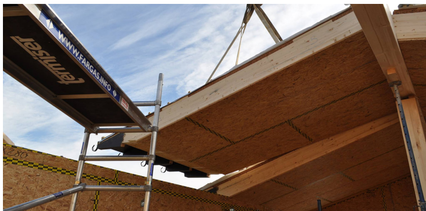
Fig. 84_Montaje del panel prefabricado de cubierta, vivienda Estrella dels Vents. Continuidad exterior-interior de las vigas estructurales ( https://www.facebook.com )
