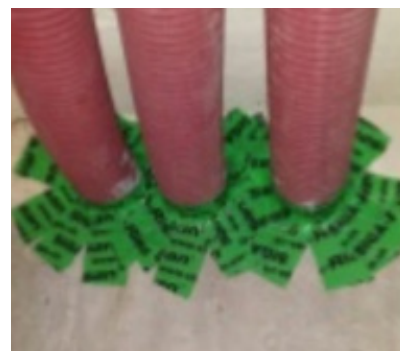
Fig. 76_Sellado hermético mediante bandas en conductos que penetran la envolvente. Rivas Passivhaus (Natural Concept, 2015)
