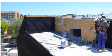
Fig. 81_Colocación exterior de la capa hermética al viento (Natural Concept, 2015)
