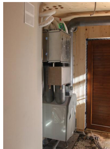
Fig. 103-104_Instalación del sistema de ventilación mecánica de doble flujo, vivienda EntreEncinas ( https://www.plataformaarquitectura.cl )
