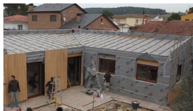
Fig. 45-47_Proceso montaje del cerramiento horizontal, entramado ligero prefabricado, vivienda PassivPalau ( http://www.papik.cat )
