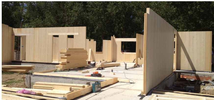
Fig. 60_Colocación de paneles de madera contralaminada KLH sobre la solera en la vivienda el Plantío ( https://www.plataforma-pep.org )
