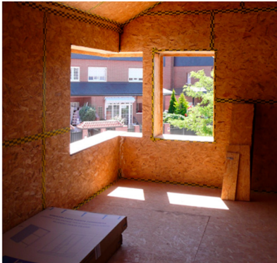
Fig. 79_Sellado de juntas entre paneles OSB mediante bandas herméticas (Natural Concept, 2015)
