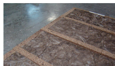
Fig. 68-69_Construcción en taller de los paneles de entramado pesado. Lana de roca al interior ( https://www.facebook.com )
