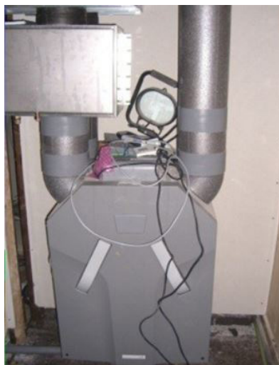
Fig. 103-104_Instalación del sistema de ventilación mecánica de doble flujo, vivienda EntreEncinas ( https://www.plataformaarquitectura.cl )
