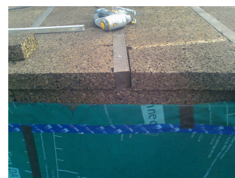
Fig. 89_Paneles de corcho de cubierta. Detalle de esquina de cubierta. Rastrelado para anclaje de la subestructura portante de las tejas ( http://casaentreencinas.blogspot.com.es )
