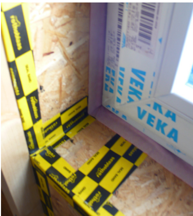
Fig. 80_Detalle de sellado. Bandas en las juntas de los paneles y en unión carpintería- envoltiente opaca (Natural Concept, 2015)
