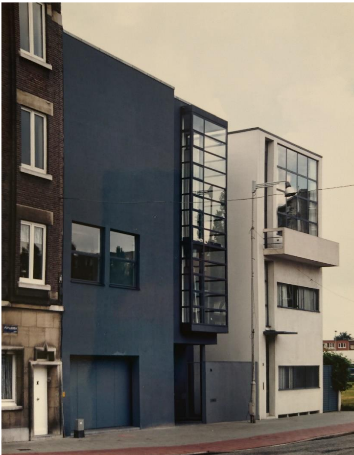
Fig. 91 Resultado tras la reforma de Georges Baines de 1987. A la izquierda de la casa Guiette vemos la primera ampliación de la casa (1993), causante de mucha polémica.
