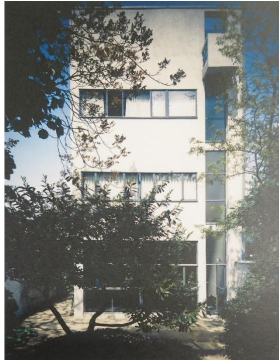
Fig. 82 Fachada trasera después de la restauración. Patrick Robyn. 1987.
