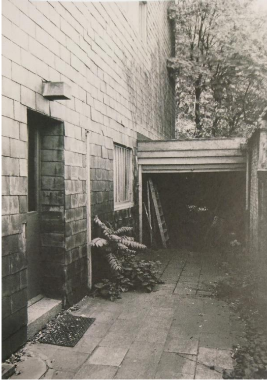
Fig. 89 Detalle de la fachada lateral después de la instalación de teja negra, llevada a cabo bajo la dirección de Paul Smekens. Después de 1945.
