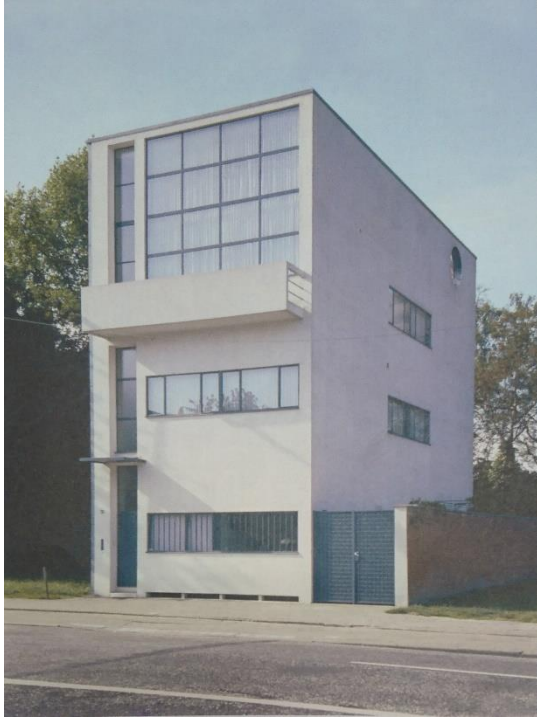
Fig. 81 Fachada delantera y lateral después de la restauración. Patrick Robyn. 1987.
