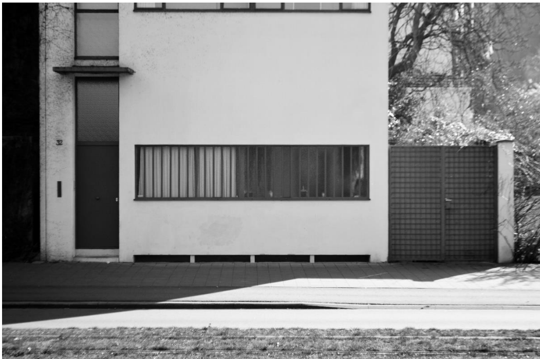
Fig. 52 Fotografía donde se observa como el jardín atraviesa bajo la planta libre de la casa y la casa "queda suspendida", a pesar de carecer de la imagen visual de cubo sobre "patas" que ofrecen los pilotis.
