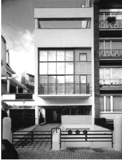
Fig. 108 Fotografía de la fachada delantera de la Maison de Verre.
