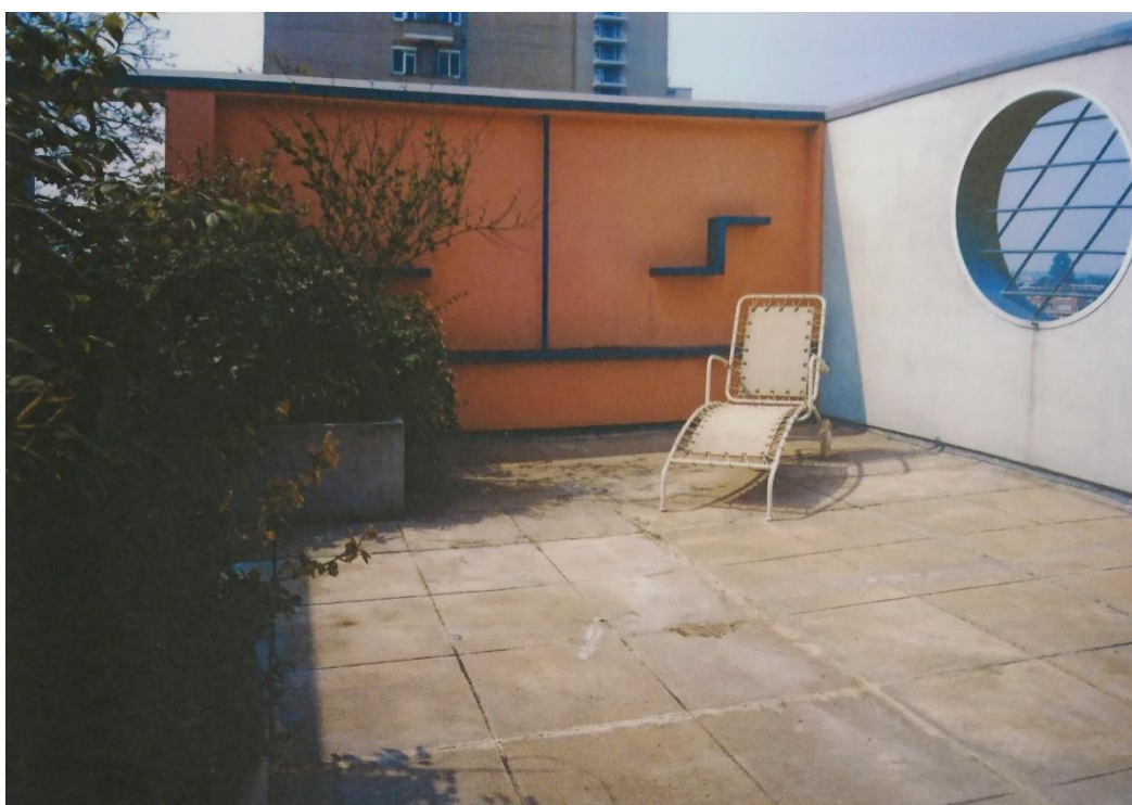
Fig. 71 Azotea de la casa Guiette después de la restauración, 1987.
