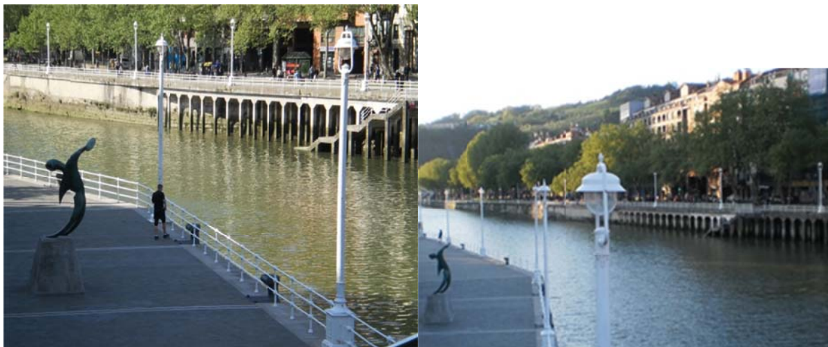
Fotografía 3. Detalle de la subida de la marea.
