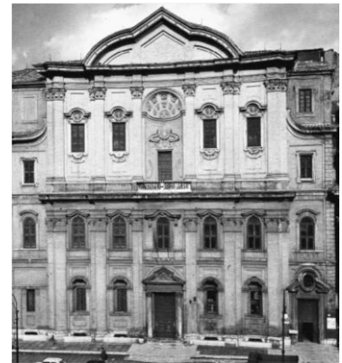
Fig. [15] - Fachada del oratorio de San Felipe Neri. Construida por Borromini entre 1637 y 1649. Fuente: (Planeta 1991).
