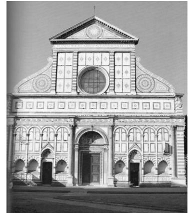
Fig. [14] - Fachada de la iglesia de Santa María Novella. Construida por Alberti entre 1458 y 1470. Fuente: (Planeta 1991)
