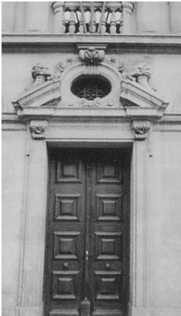
Fig. [20] - Reinterpretación estética del frontón que le ha privado de su función de evacuación de aguas. Fuente: (Revista Técnica 1997)
