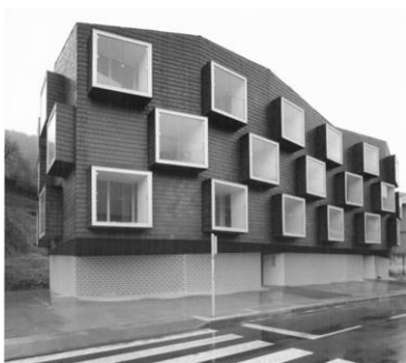
Fig. [21] - Fachada sur del proyecto de 15 Viviendas Sociales en Degaña, Asturias, España. Arquitectos Nacho Ruiz Allén y Jose Antonio Ruiz Esquiroz. Fuente: Revista temas de arquitectura 13
