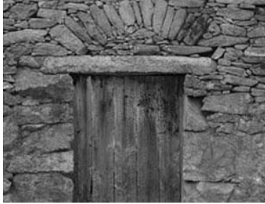
Fig. [6] - Hueco limitado por la necesidad de transmisión de cargas. Muro de carga de piedra con dintel horizontal ayudado por la disposición arqueada de las piezas de mampostería superiores. Fuente: territorioveton.blogspot.com
