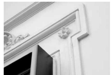
Fig. [73] - Detalle del encuentro de la caja contemporánea de carácter atemporal y el detallado contorno en revoco del hueco original. Fuente: Octavio MEstre
