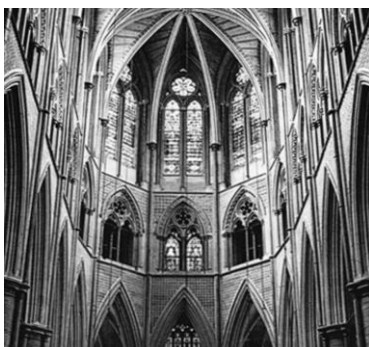
Fig. [13] - Interior del ábside de la abadía de Westminster. Construida a mediados del siglo XIII. Fuente: (Planeta 1991)
