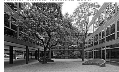
Fig. [45] – Estado de la escuela tras la rehabilitación en 2006. En la imagen podemos ver el tratamiento que se dio a los huecos de la fachada del patio. Fuente: (Revista tectónica 2000)
