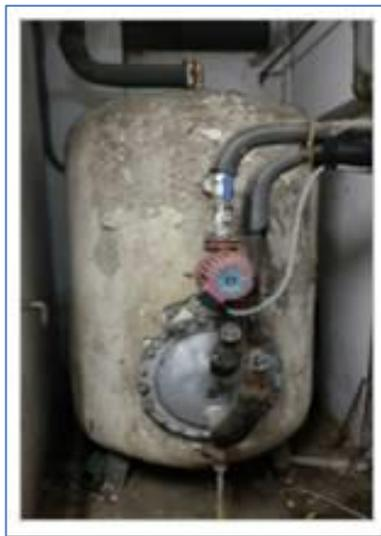
*Figura 8. Tanque de acumulación de agua caliente sanitaria*
