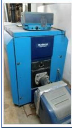
Figura 3. Caldera y quemador de la instalación
