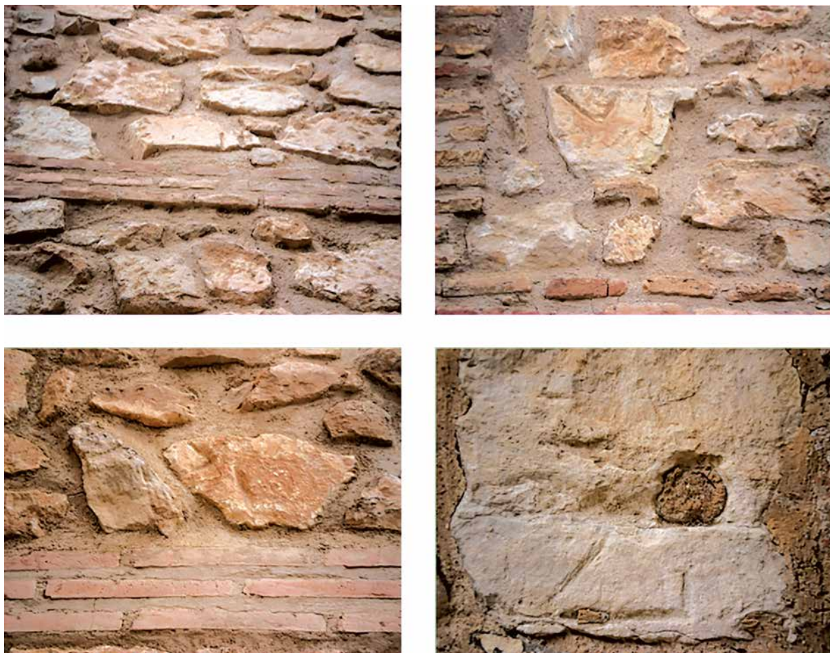
Figura 1. Detalle de algunos de los fragmentos de sillares con marcas epigráficas procedentes de la presa romana empleados en la construcción del muro norte de la Ermita de Ntra Srta de las Aguas en Muel.
