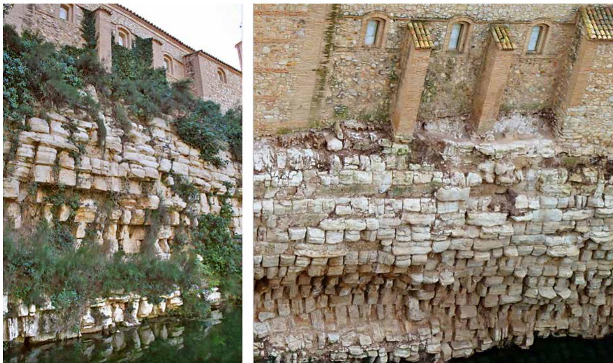
Figura 2. Paramento aguas abajo de la presa de Muel. A la izquierda, estado previo a su limpieza. A la derecha, el mismo paramento en el año 2010, después de eliminar la vegetación.
