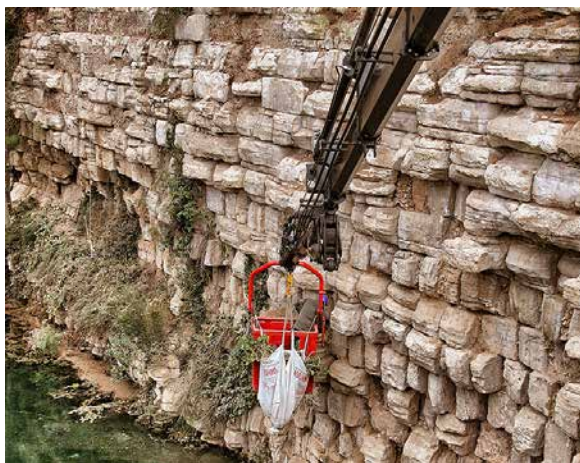
Figura 3. Proceso de limpieza manual del paramento aguas abajo, realizado en 2010.
