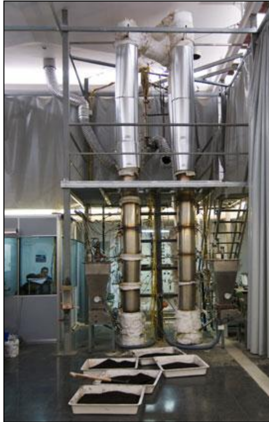
Figura 20. Fotografía del interior de la instalación del INCAR [2]
