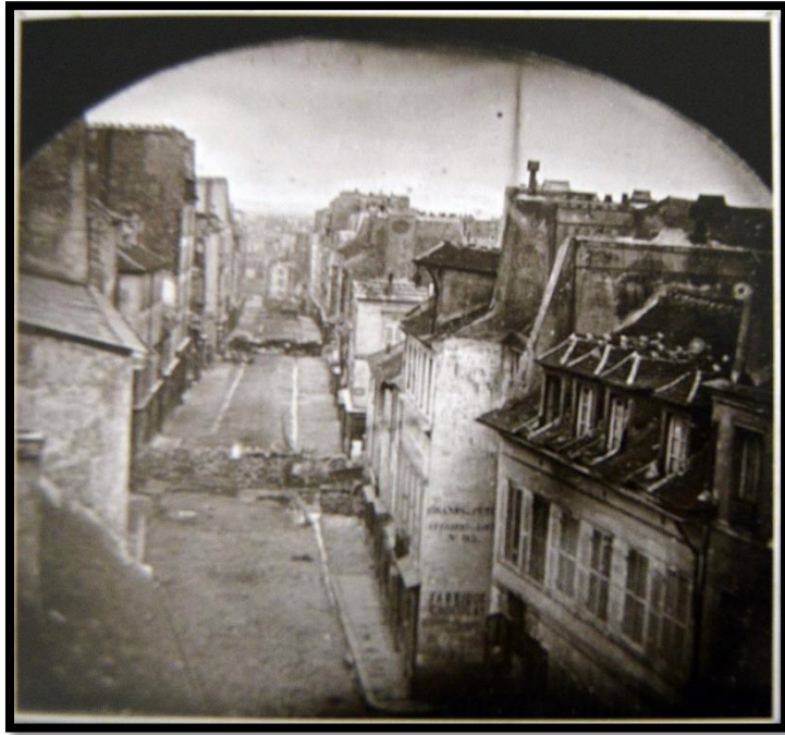
Figura 10. Fotografía de una barricada
