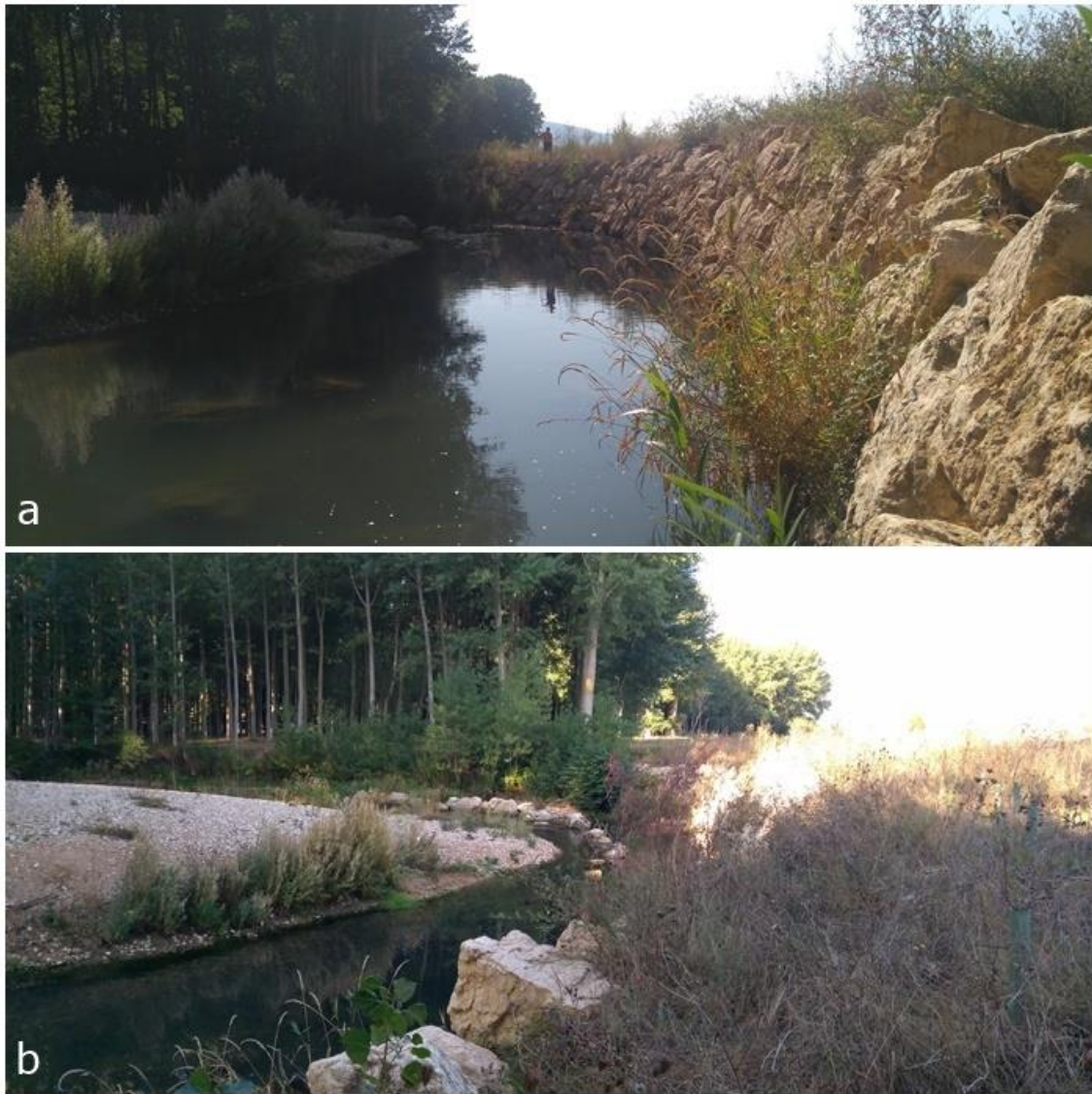
Figura 10. a) Escollera construida en la margen izquierda del río Ega. b) en el cauce, se pueden observar los bloques caídos fruto de la erosión de una escollera anterior. (Fuente: elaboración propia).
