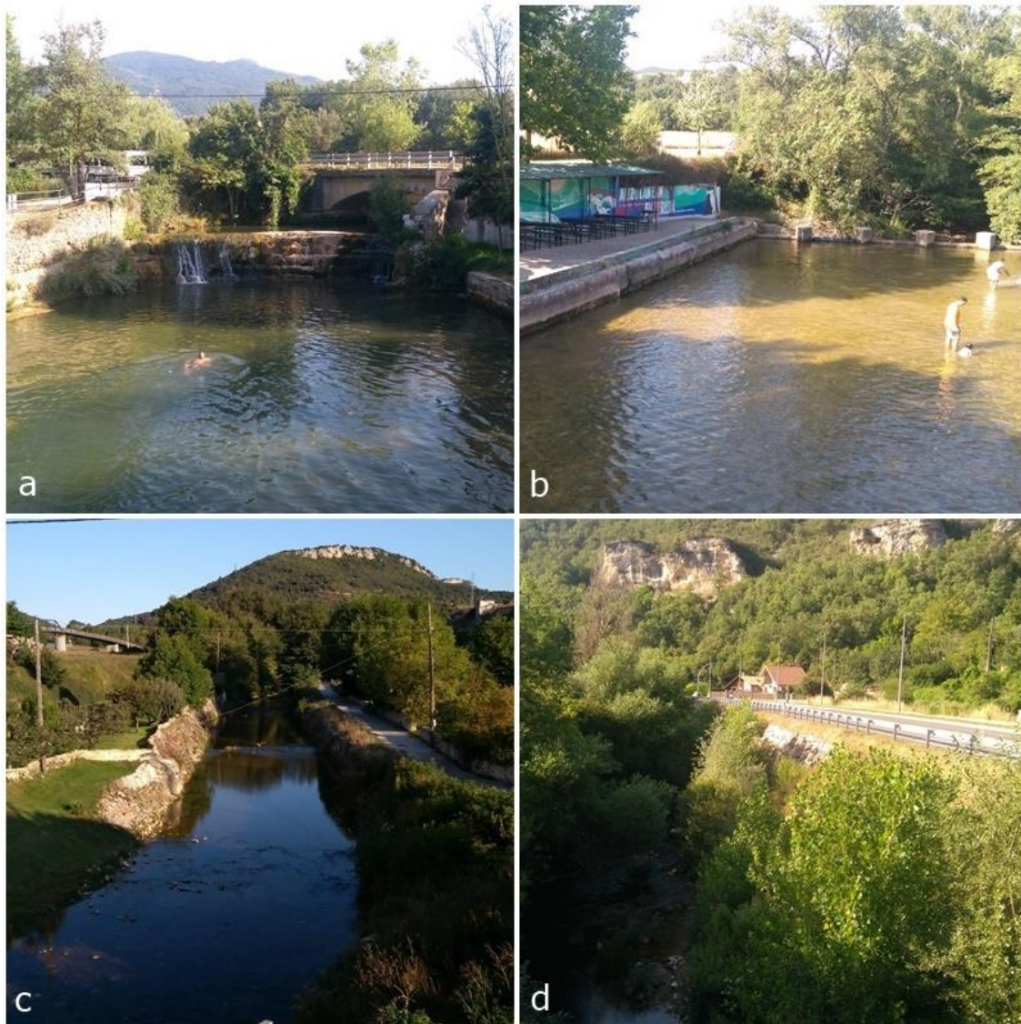
Figura 11. Presiones negativas existentes en el tramo de la subcuenca del río Berrón. A) Azud y encauzamiento lateral del río Berrón. B) Puente y encauzamiento del río Berrón mediante muros de hormigón para dar lugar a las piscinas naturales. C) Encauzamiento del río Berrón mediante escolleras, a su paso por la localidad de Antoñana, como medida para proteger el casco urbano del lugar. D) Escollera construida para proteger la carretera del río Berrón.
