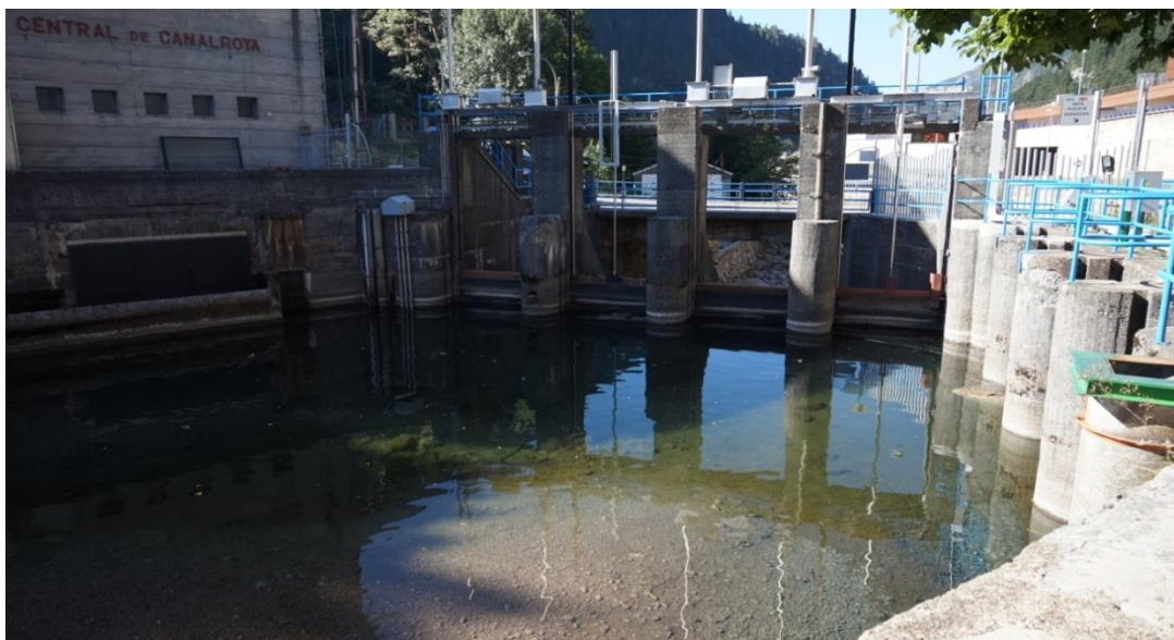
Foto 5: Presa de la central hidroeléctrica de Canalroya.
