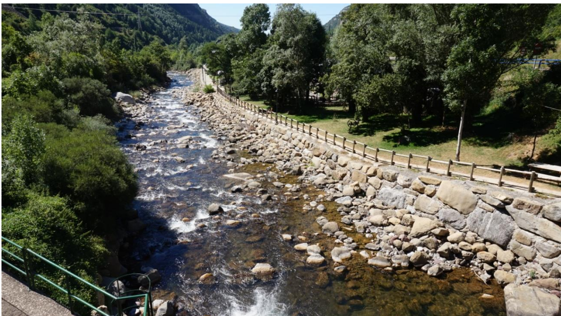
Foto 8: Canalización del la parte derecha del río Aragón a su paso por Canfranc
