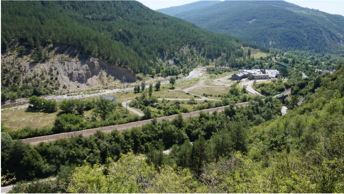
Foto 10. Vista del río Aragón a su paso por Castiello de Jaca
