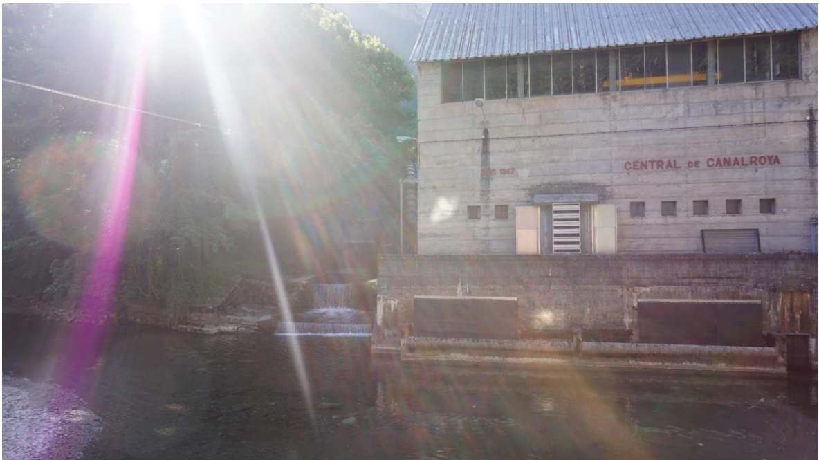
Foto 4: Presa de la central hidroeléctrica de Canalroya.
