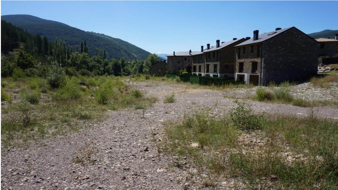
Foto 12. Urbanización El Molino situada dentro del cauce del río Aragón
